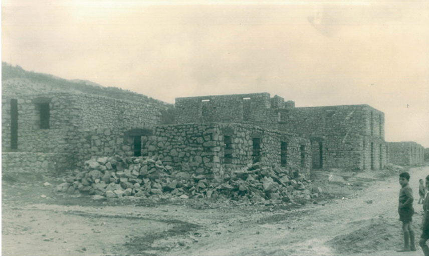
Construcción de viviendas tipo Belén en Cárcheles Fuente: Ayuntamiento de Cárcheles
