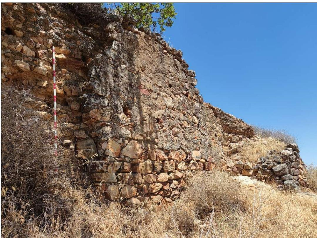
Fig. 184. Posible tapial de mampuesto sobre zócalo pétreo. Al fondo, basamento de la torre en esquina adosada al muro del recinto superior
