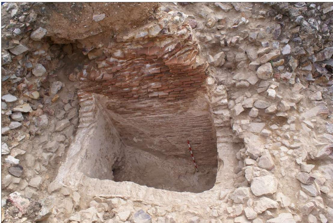
Fig. 209. "Aljibe chico". *Detalle del arranque de su bóveda y sobre esta, cuerpo de tapial*
