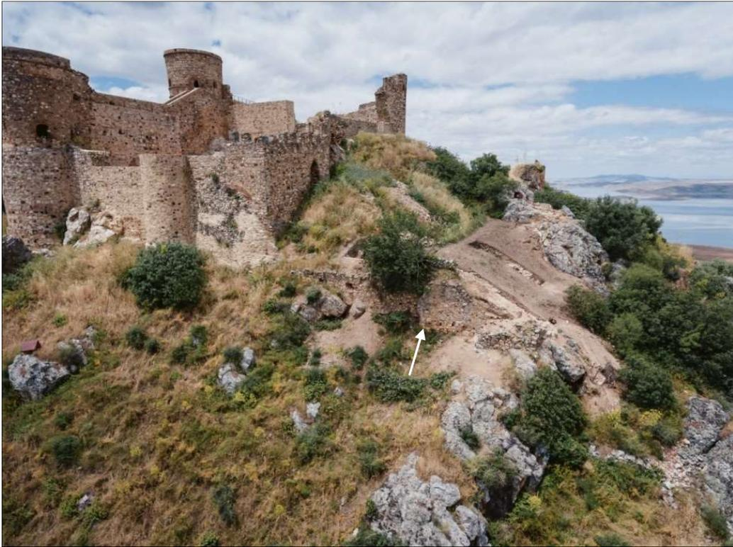
Fig. 26. *Vista del ángulo oriental del recinto superior. La flecha indica la cara externa del muro rematado con tapial*
