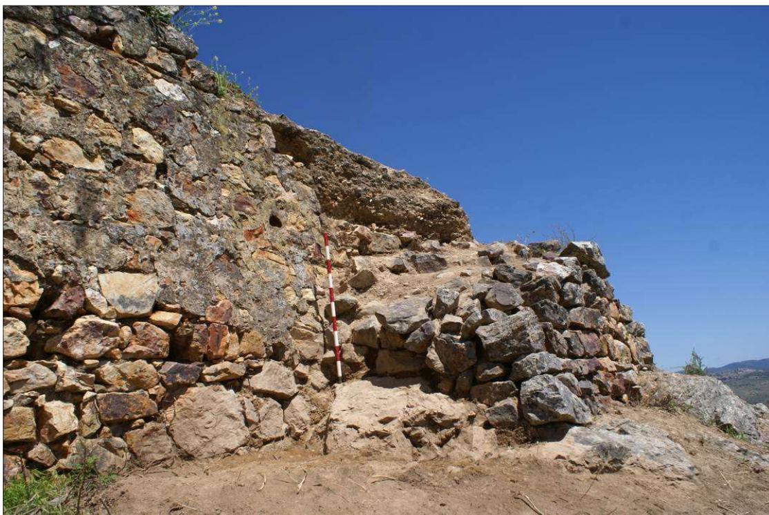
Fig. 53. Vista exterior: basamento de la torre Ue 40.012 adosado a la muralla Ue 40.007 -a la izquierda-; sobre el basamento, alzado de tapial Ue 40.013 apoyando además en la muralla Ue 40.007
