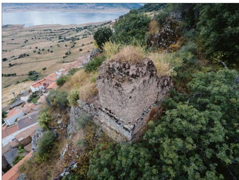
Fig. 185. *Cubo de tapial sobre basamento pétreo situado al norte del recinto intermedio*
