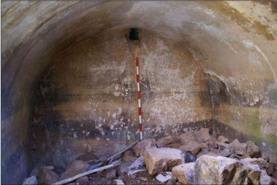
Fig. 207. *Una de las bocas de alimentación del “Aljibe grande” situada en la sala central*
