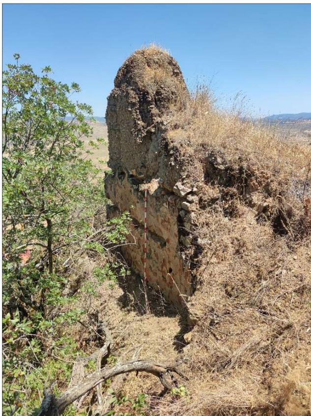
Fig. 186. *Cubo de tapial situado sobre basamento pétreo al norte del recinto intermedio*
