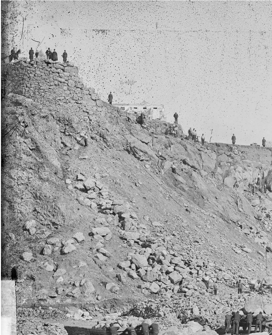
Fig. 12b. Detalle de la fig. 4 (talud tras desmontar los carriles)
