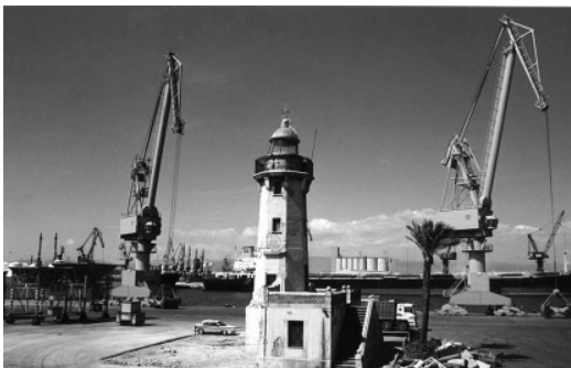
Figura 1 Derribo del edificio del faro y no de la torre. Muelle de Aragón (APT- M Caro, 27.3.1997, reg. 5233)
