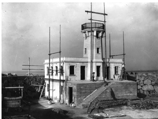
Figura 13 Construcción del faro en el dique de levante (APT- s/f, ca.1922, reg. 1543)
