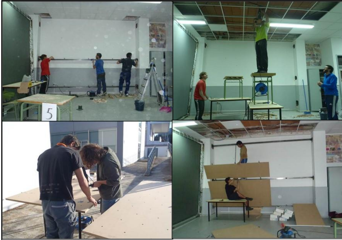
Figura 4.60. Técnicos y autor trabajando en las diferentes fases de construcción del rocódromo.
