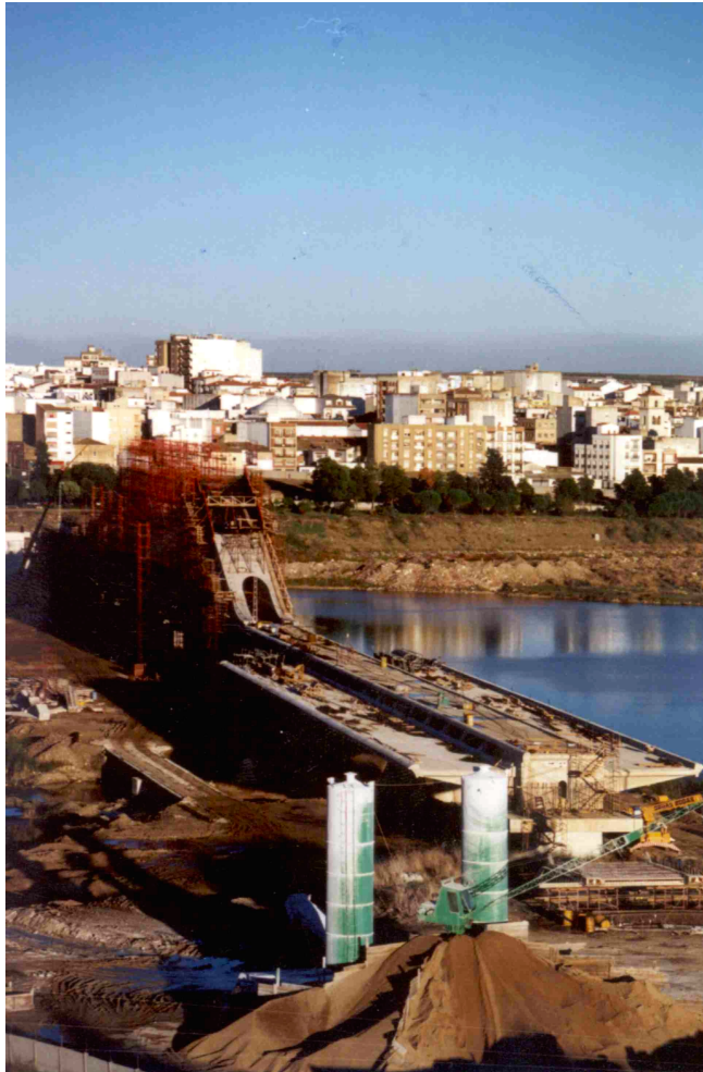
Ilustración 1.6.15. Edificación del Puente Lusitania. Foto cedida por el Archivo Histórico Municipal de Mérida.
