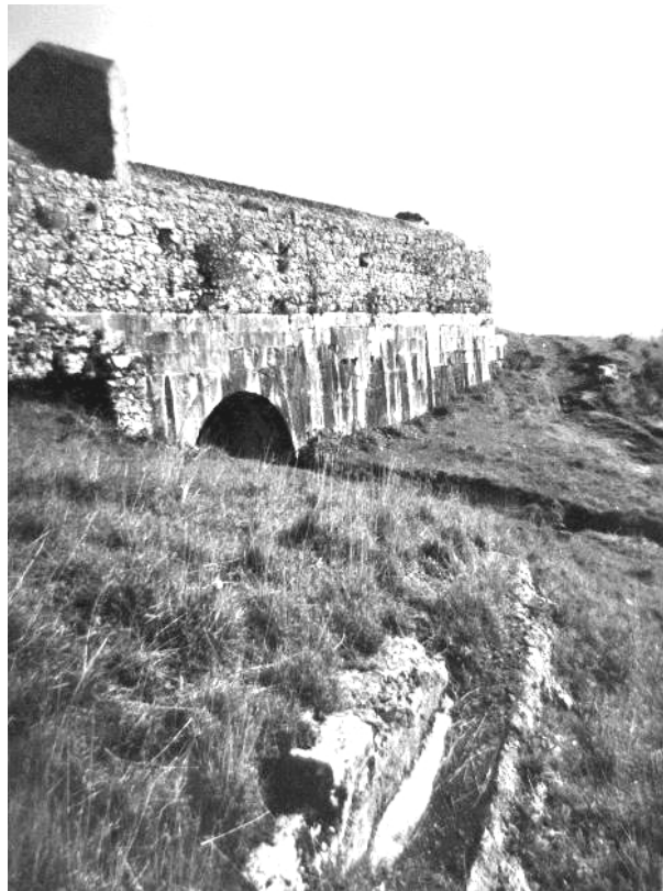
Fig. 89. – Troço do grande aqueduto romano proveniente da barragem romana de Belas, no vale de Carenque (Amadora).
