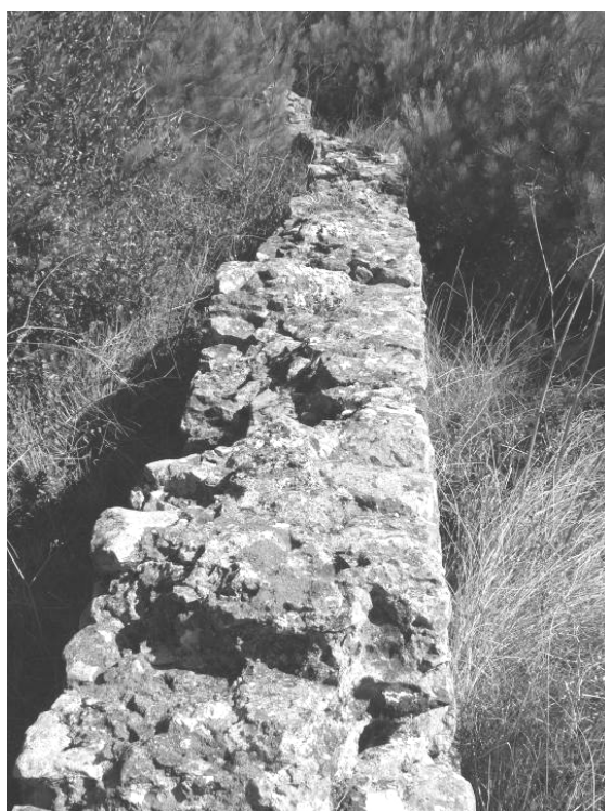
Fig. 91. – Troço do aqueduto romano da villa de Cascais Velhos (Cascais).
