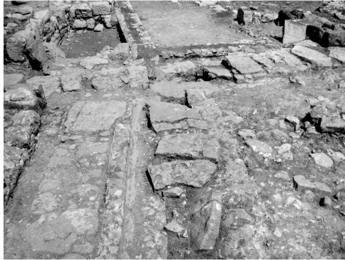
Fig. 97. – Cloaca entre a pars urbana e as termas. Observa-se a cobertura feita por lajes a cobrindo o canal de esgoto, apoiando-se sobre o antigo aqueduto entretanto desactivado.
