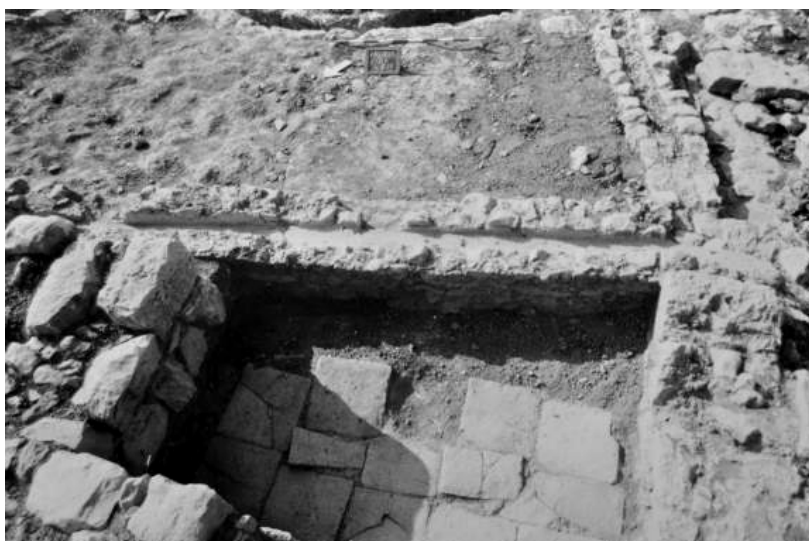
Fig. 86. – Aqueduto entre o lagar e as termas Norte.
