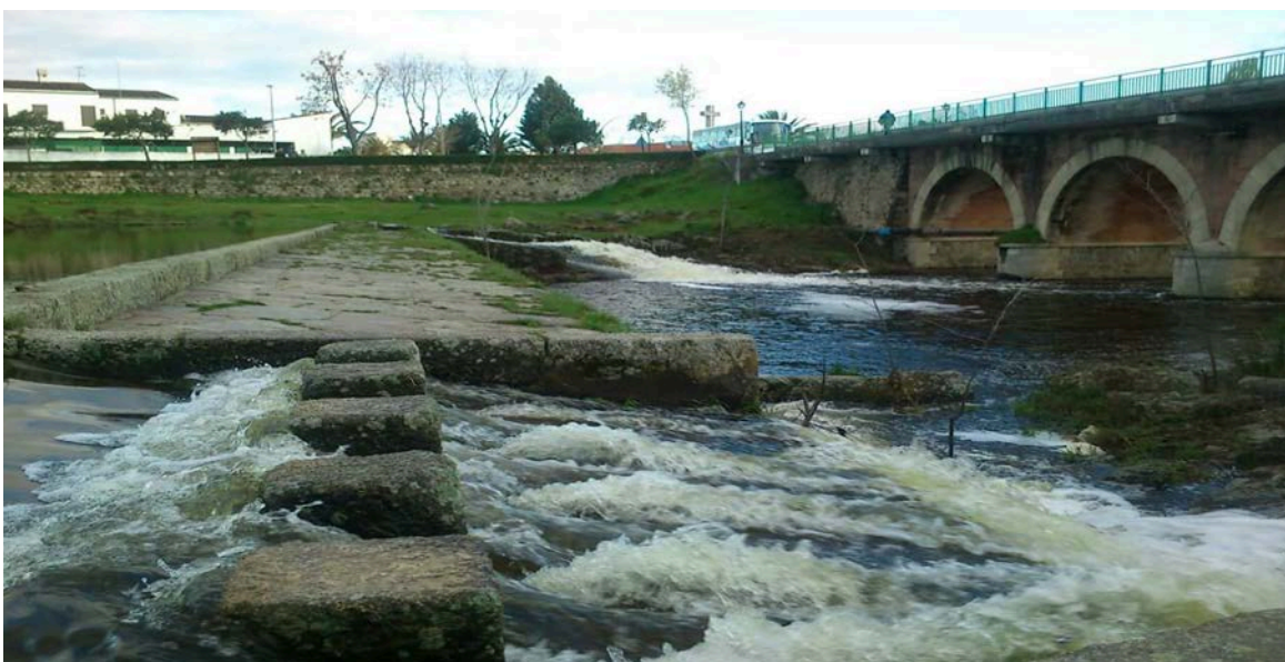
Presa sobre el río Pontones a su paso por Arroyo de la Luz (Cáceres).
