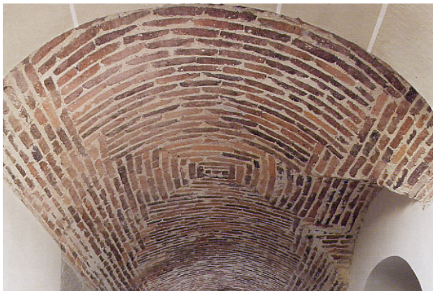
Bóvedas de ladrillo del pasadizo del Patio de Novicios
