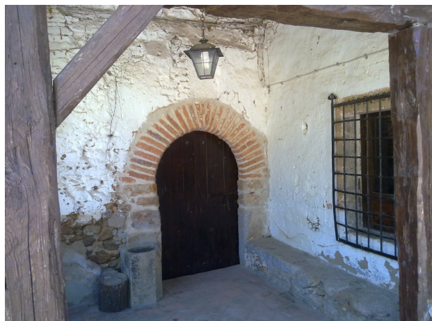
Acceso porticado del refectorio y cocina
