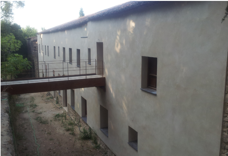
Calle de los Oficios en el exterior del frente oriental del claustro renacentista
