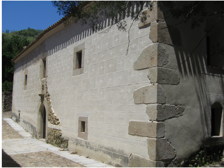
Casa del Obispo. Estado actual
