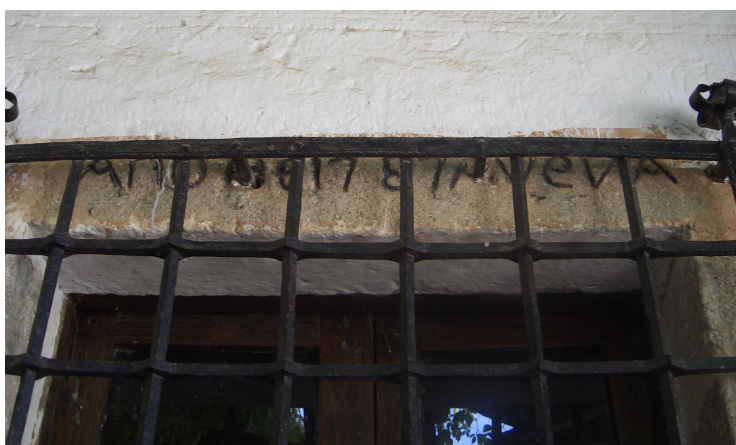
Detalle de ventana de uno de los edificios principales
