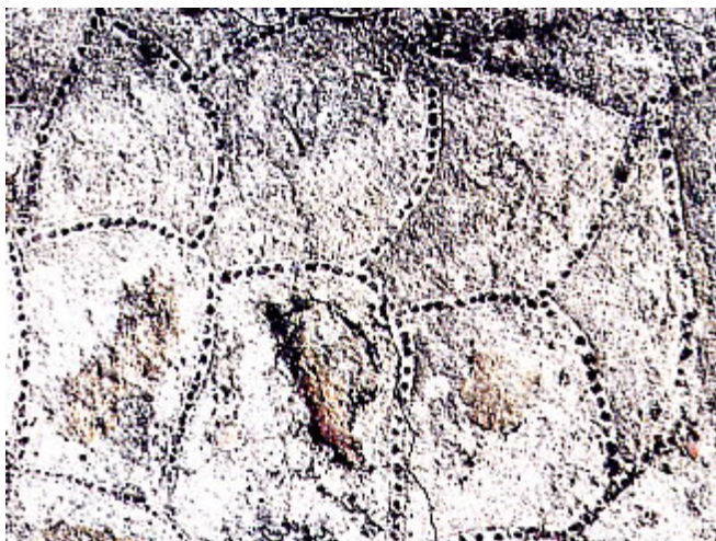
Decoración de “gotas de agua” realizada con mortero de cal
