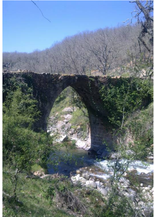
Puente sobre la garganta Jaranda
