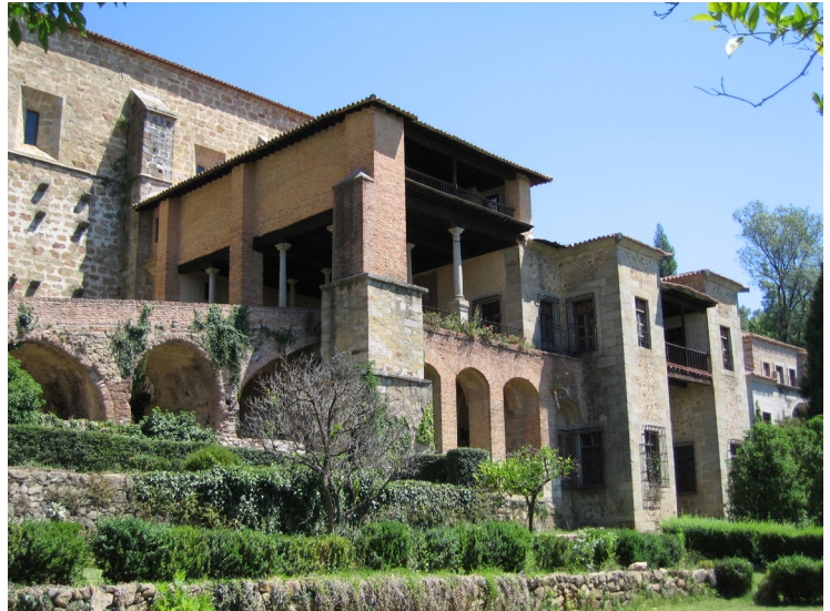
Vista de conjunto del palacio desde el sur
