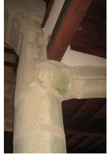
Testigo de arranque de arcos de la iglesia primitiva en el claustro gótico
