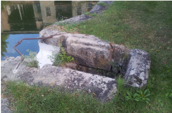
Aliviadero del azud
