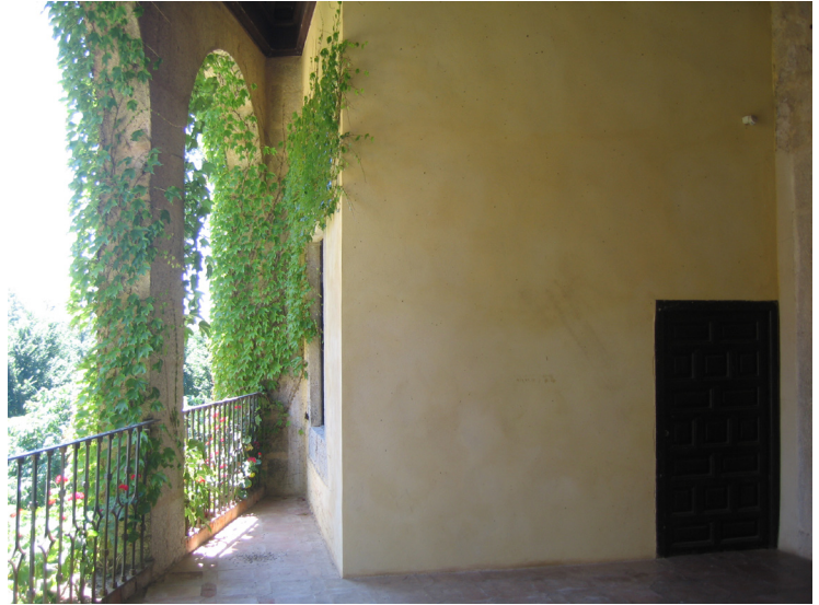
Cuerpo del “cuarto de la estufa” en la Galería del Emperador
