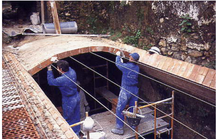
Utilización de la técnica de las bóvedas tabicadas sin cimbra para la Casa del Obispo
