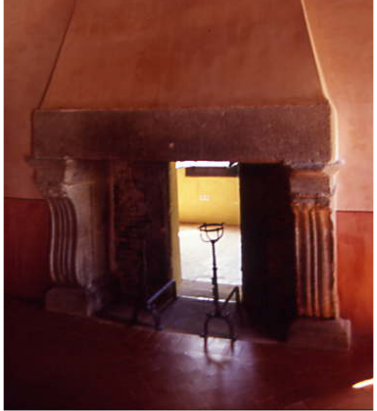
Chimenea con el hueco practicado para la estufa
