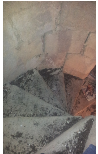
Escalera de caracol
