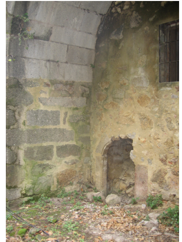
Exterior del cuerpo de la escalera de caracol
