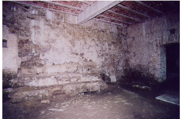
Restos de la cocina inferior bajo el claustro renacentista y del sistema de decantación del agua de Juanelo Turriano
