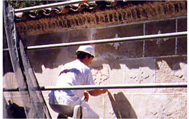
Reparación de los esgrafiados y revocos de la Casa del Obispo
