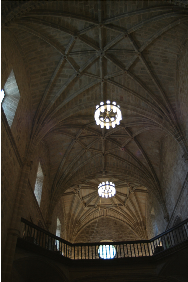
Bóvedas de la iglesia
