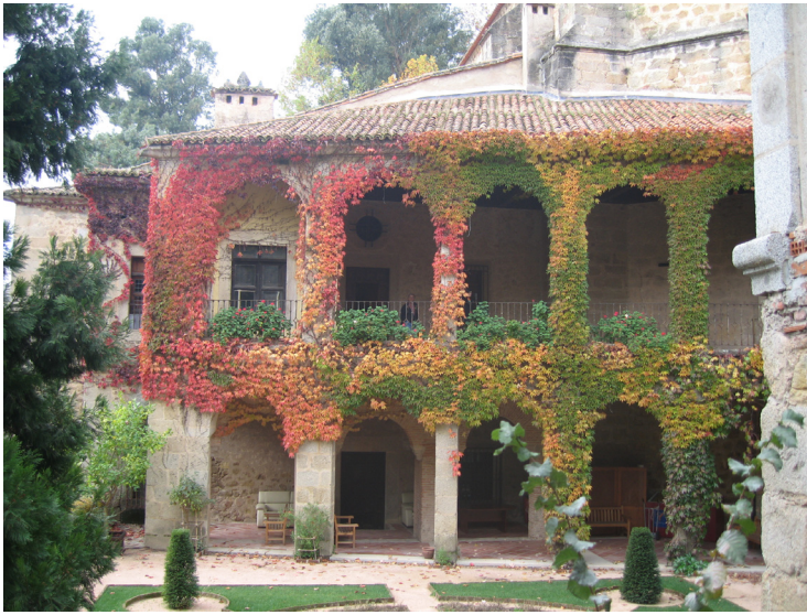
Frente occidental de la “Galería del Emperador”
