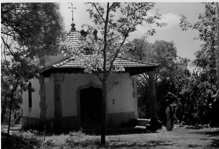
Estado de la ermita de Belén tras la intervención de González Valcárcel
