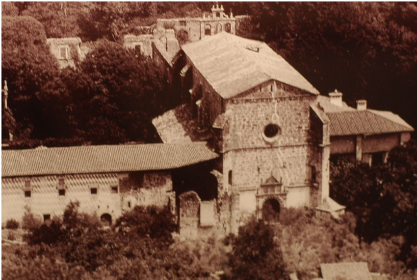
Pormenor de la fotografía de Laurent (finales del siglo XIX) en la que se aprecian los restos de la torre junto a la iglesia
