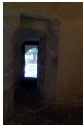
Puerta-ventana de la cripta
