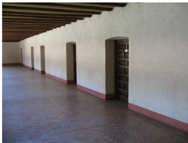
Estado actual del frente oriental del piso superior del claustro
