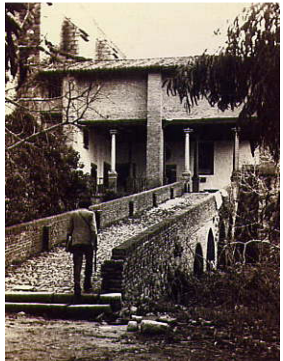
Palacio y rampa-puente en 1935-6. Foto A. Conte
