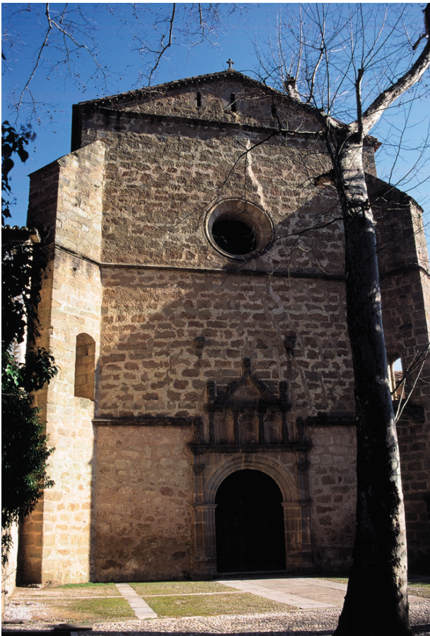
Fachada occidental de la iglesia
