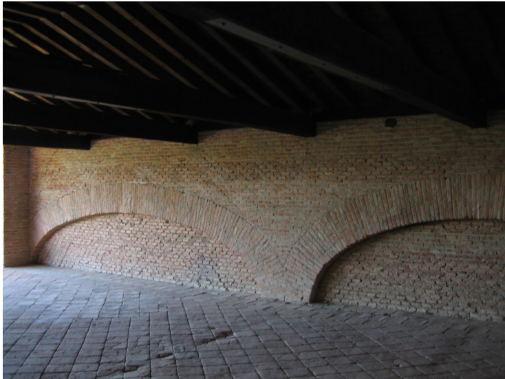
Arcos de descarga de ladrillo en el "Caramanchón"
