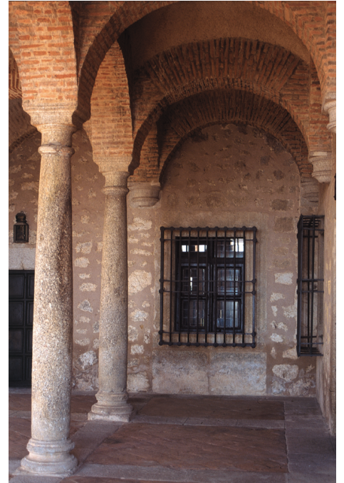
Ventanas de la planta baja del palacio
