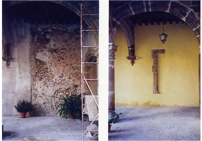
Acabado final de los paramentos del claustro renacentista
