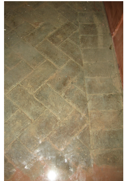
Solado original del palacio descubierto en las operaciones del proyecto "Yuste"
