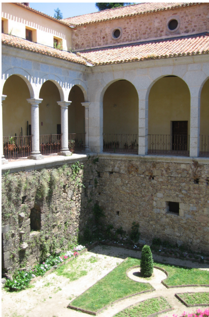
Galería del Emperador tras la intervención de González Valcárcel
