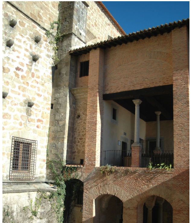
Zona de contacto entre la iglesia monacal y el palacio
