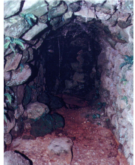
Mina de agua de Belén antes de las obras de adaptación
