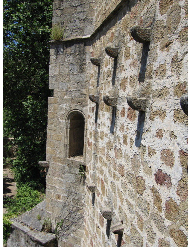
Ménsulas del muro meridional del templo
