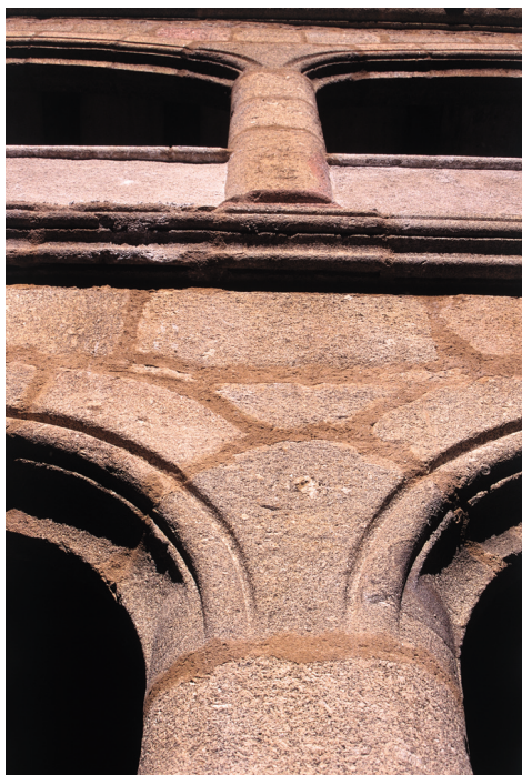
Detalle de las arcadas del claustro gótico
