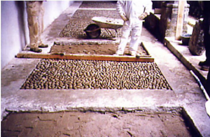
Pavimentos de enmorillados para las galerías inferiores de los claustros
