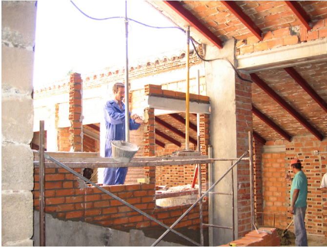
Obras en el bajo cubierta del palacio para la instalación de las dependencias de la Delegación de Patrimonio Nacional
