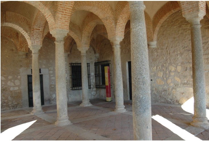
Pórtico que cobija la entrada a la planta baja del palacio
