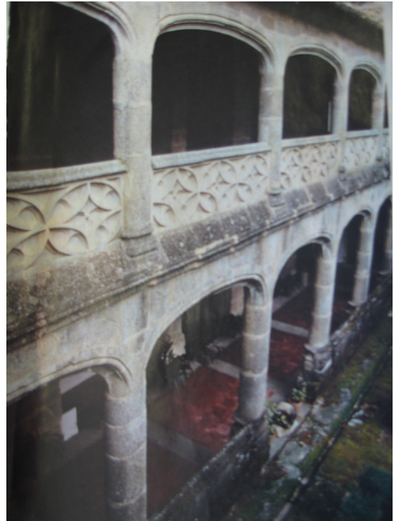
Claustro gótico con el antepecho de piedra artificial. Archivo fotográfico del I.P.C.E.
