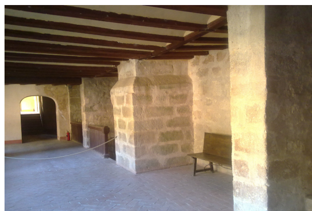
Frente meridional, contrafuertes de la iglesia y Paso del Sacramento”
