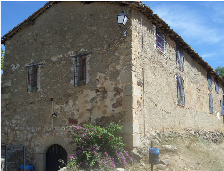
Edificio de las celdas y bodega
