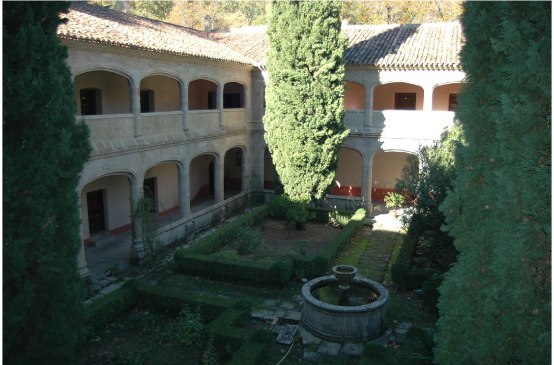
Claustro gótico. Crujías occidental y norte
