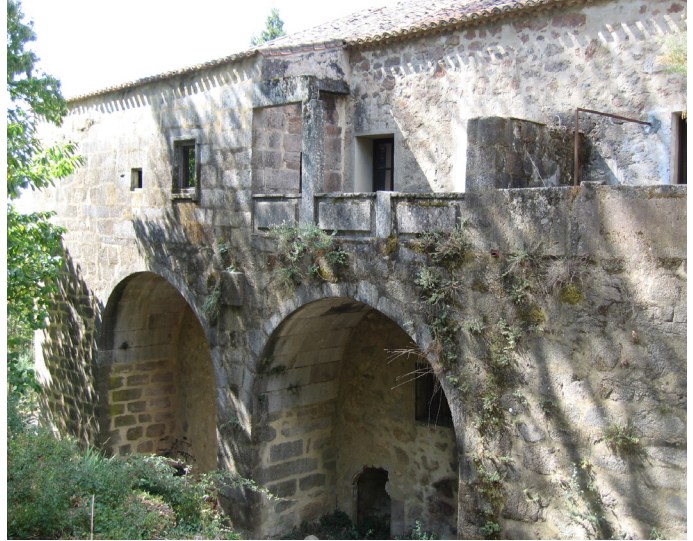
Fachada oriental de las dependencias del palacio anexas al claustro renacentista
