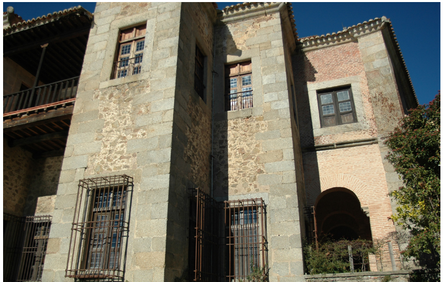
La combinación de mampostería, cantería granítica y ladrillo protagoniza el aspecto formal del palacio.
