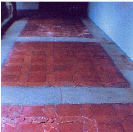
Losetas del claustro gótico tras la intervención de González Valcárcel
