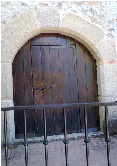
Puerta de uno de los edificios principales
