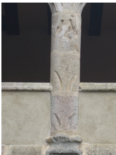
Testigos de la antigua estructura del claustro gótico
