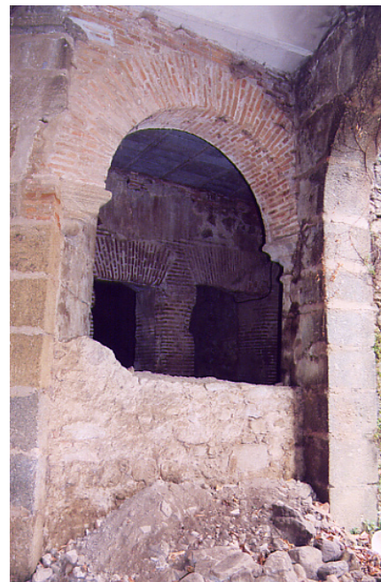
Restos de las arcadas inferiores originales de la “Galería del Emperador”
