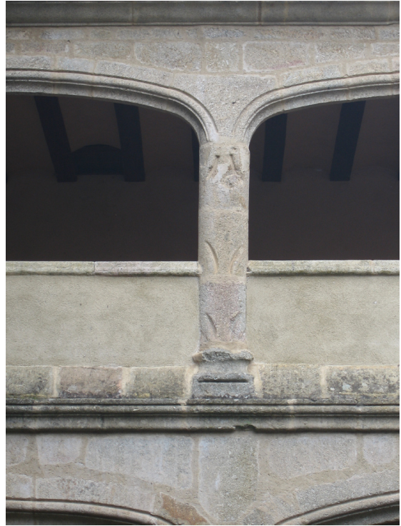
El granito ha sido el material arquitectónico por excelencia en la historia constructiva del monasterio
