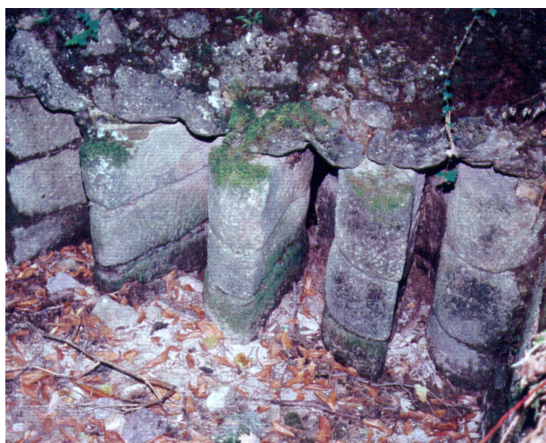
Filtro a la entrada del agua de la garganta
