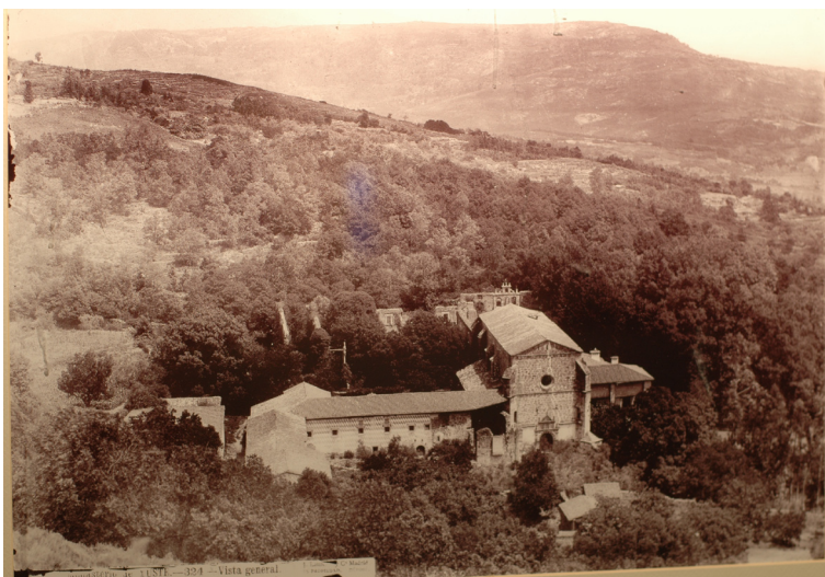
Estado del monasterio a fines del siglo XIX. Laurent
