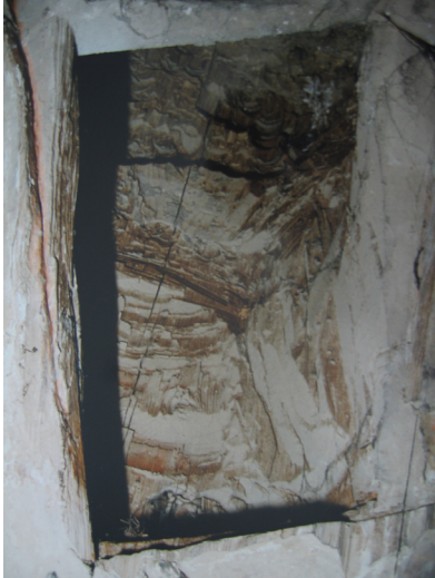
Detalle del embón ahuecado de las esculturas del ático. Archivo fotográfico del I.P.H.E.
