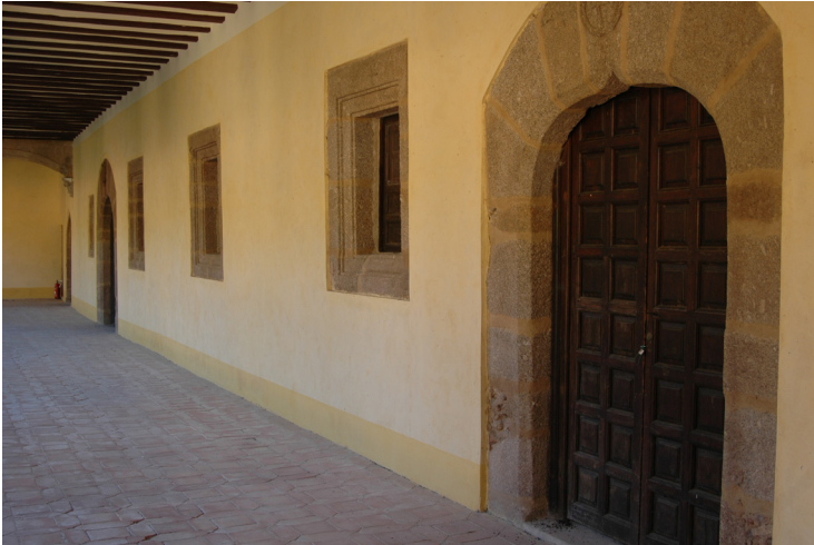
Piso superior del frente meridional
