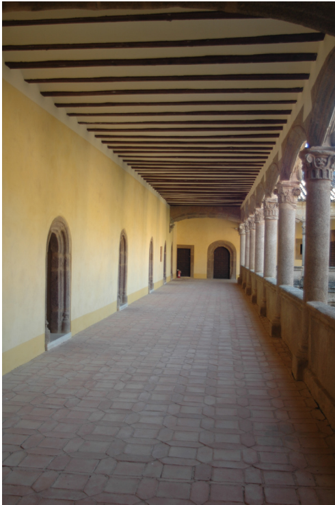
Celdas del piso principal del frente oriental del claustro renacentista
