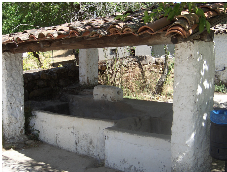
Granja de Valmorisco. Pilas para apagar la cal
