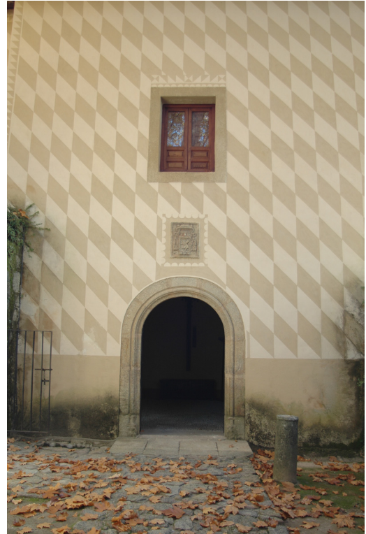
Fachada principal de la Portería del Monasterio
