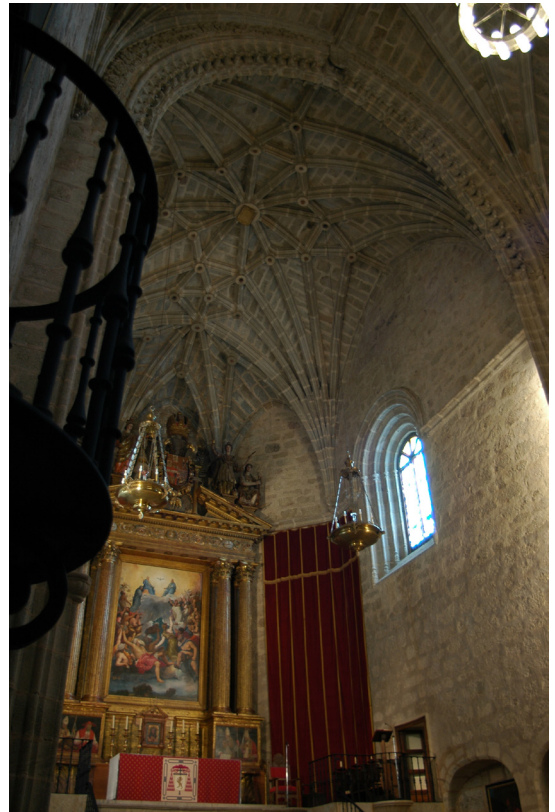
Bóvedas del presbiterio y arco toral
