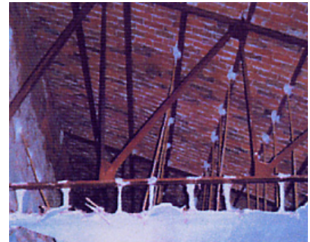
Cerchas metálicas de la intervención de González Valcárcel
