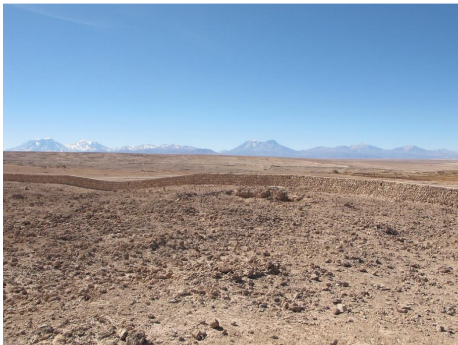
Figura 9. Muro levantado por la comunidad para proteger las ruinas del pukara de Chiu-Chiu (2013)
