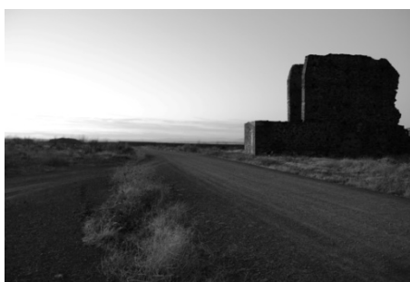
Fig. 4.147. Castillete de la mina de la “Gamonita” y camino que une el campo de concentración con Castuera. Fotografía cedida por Zahira Aragüete Toribio.
