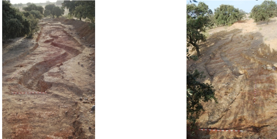
Fig. 4.189. Trinchera de “El Chaparral” totalmente excavada una vez finalizada la intervención, izquierda: vista desde el oeste/ derecha: vista desde el este.
