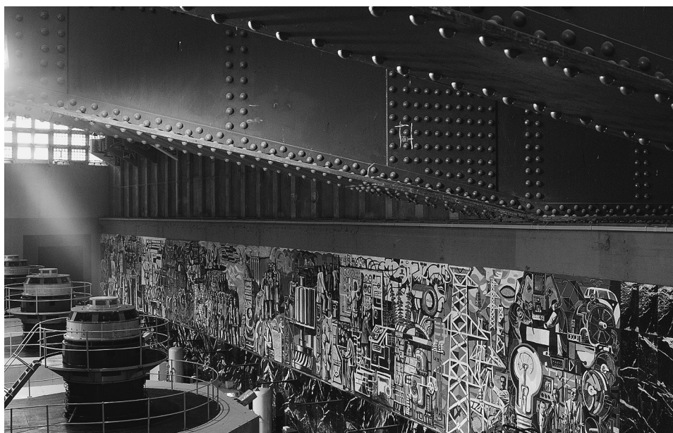
FIG. 5. Sala de turbinas con la representación, en la pared aguas arriba, de un gran mural figurativo que, siguiendo un discurso cronológico, relata la construcción del Salto de Salime. Fotografía: Pedro Timón Solinis.
