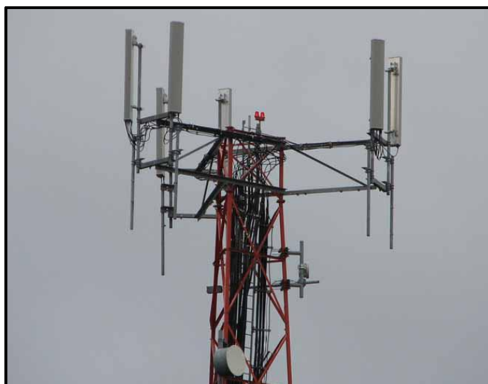
Figura 3: Torre de telefonía móvil
