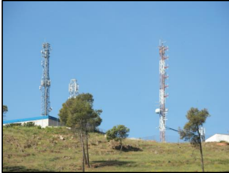
Figura 7: Antenas de FM junto a la Estación de Renfe de Cáceres
