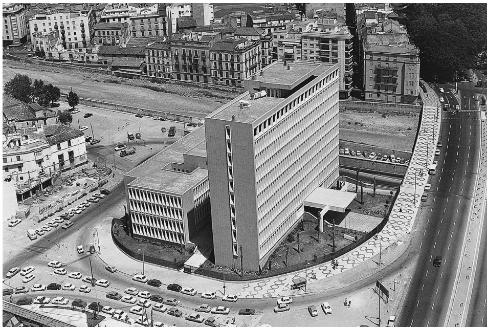
FIG. 6. E. Caballero y J. L. Dorronsoro, Delegación de Hacienda en Málaga, 1975-1979. Vista aérea de las fachadas sur y oeste, 1979.
