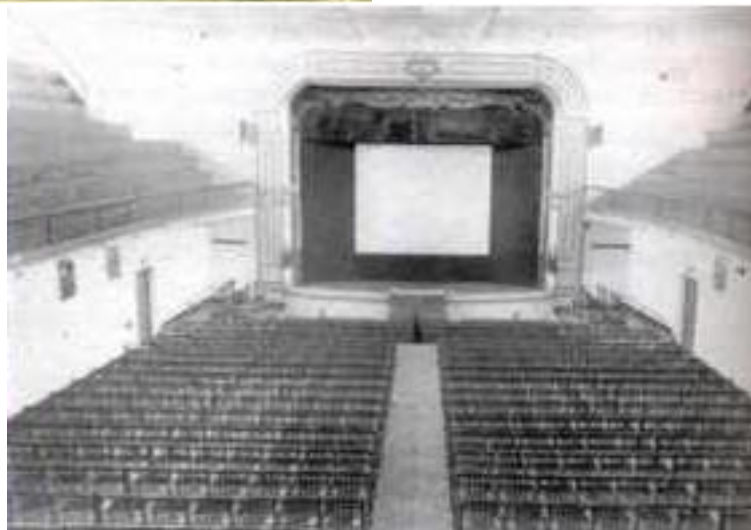
Figura 1393 y 1394. Fotografías del Teatro Salón Romero de Zafra (Fotografías aportadas por el arquitecto municipal del Ayuntamiento de Zafra, BENITO, J.).
