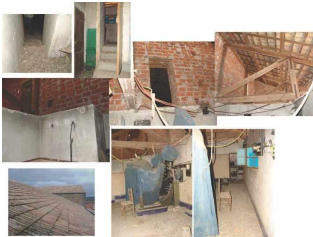
Figura 787. Cabina y cubierta antes de la rehabilitación (GALLEGO CANO, A.).
