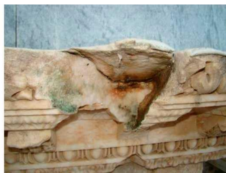
Figuras 221 y 222. Vista superior de fractura y posible desprendimiento, hueco de fractura una vez retirado el fragmento (LUENGO, F. y PEREZ CHIVITE, M.P., 2014).
