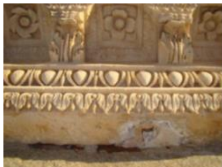
Figuras 223 y 224. Deterioro de los morteros de recubrición de las grapas, en diferente intensidad. (LUENGO, F. y PEREZ CHIVITE, M.P., 2014).
