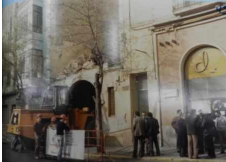
Figura 275. Comienzo de las obras de demolición y su paralización por parte de los grupos socialista y comunista del Ayuntamiento de Badajoz (AHPC).
