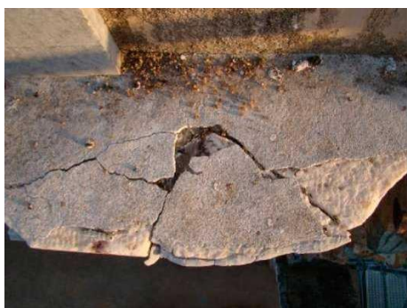
Figuras 221 y 222. Vista superior de fractura y posible desprendimiento, hueco de fractura una vez retirado el fragmento (LUENGO, F. y PEREZ CHIVITE, M.P., 2014).
