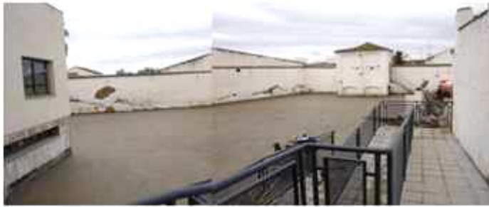
SOLERA EXTERIOR EN CINE DE VERANO
