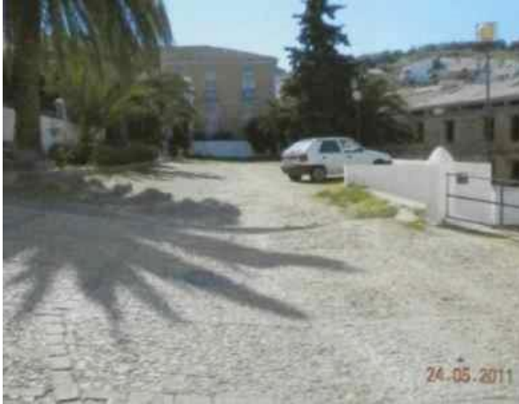
Figura 356. Empedrado existente. Figura 357. Empedrado en mal estado (BARCO, E., 2011).
