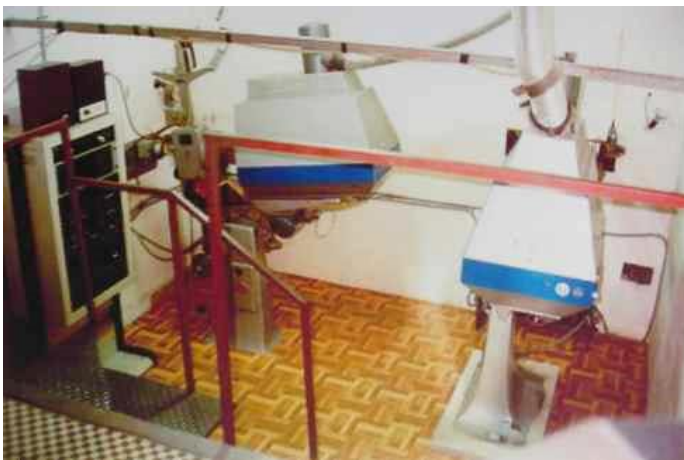
Figura 584. Nivel inferior de la cabina de proyección (planta segunda). En la parte izquierda está la cámara de la sala principal, y la del minicine a su derecha. Esta última proyecta la imagen reflejándola en dos espejos para salvar la altura entre el objetivo del proyector a 1,20 metros y la ventana del minicine, que se encuentra enrasada con el suelo. El equipo de megafonía se encuentra a la parte izquierda de la foto. Figura 585. Nivel superior de la cabina de proyección. En la parte inferior de la foto se encuentra la escalera metálica que salva el desnivel entre ambas zonas. En la zona superior están los platos donde se colocan las películas para la proyección. Las películas discurren desde estos platos hasta las cámaras mediante un sistema de poleas (VALVERDE LORENZO, L.R, 1996).
