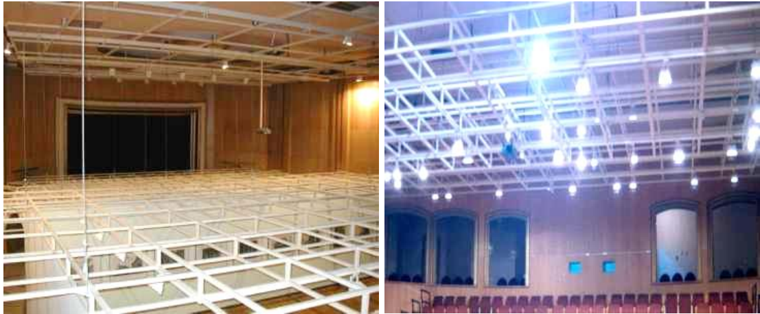
Figuras 895 y 896. Fotografías del techo estructural para la iluminación de la Sala Multiusos Capitol (GONZÁLEZ GARCÍA, A.).
