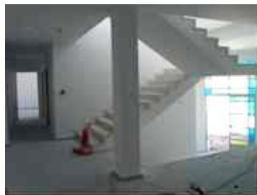
CAMERINOS. REVESTIMIENTO SUELO Y ESCALERA. CARPINTERIA EXTERIOR
