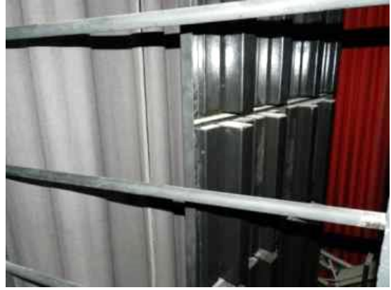
Figura 1108. Paneles absorbentes tras la rehabilitación. Figura 1109. Concha acústica tras la rehabilitación.
