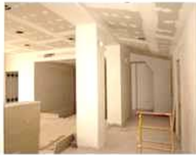
REVESTIMIENTO TECHO VESTIBULO
