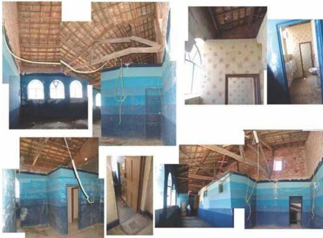
Figura 786. Segunda planta antes de la rehabilitación (GALLEGO CANO, A.).
