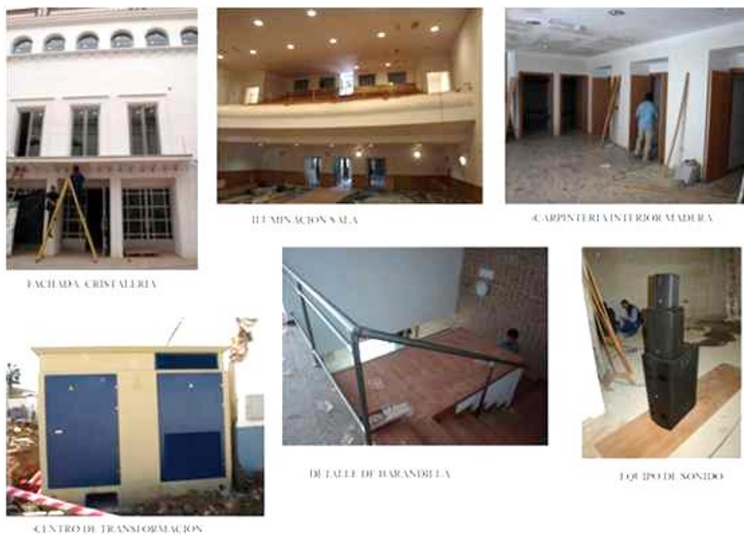
Figura 811. Fachada (cristalería), iluminación sala, carpintería interior madera, centro de transformación, detalle de barandilla y equipo de sonido (GALLEGO CANO, A.).
