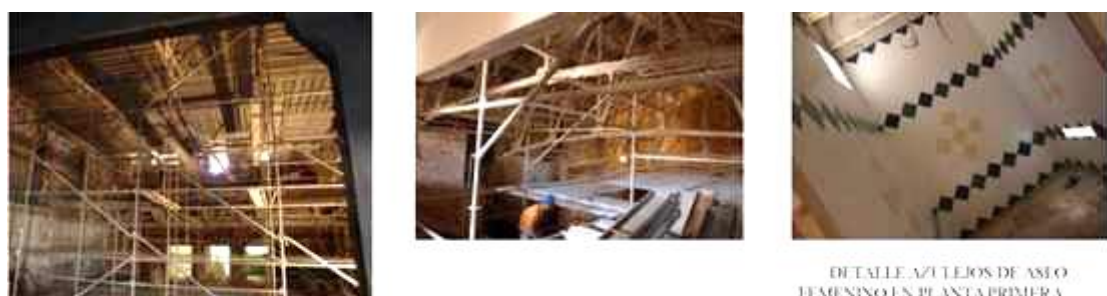
TRATAMIENTO IGNIBUGO DE CERCHAS METÁLICAS DE NAVE DETALLE ANDAMIAJE
