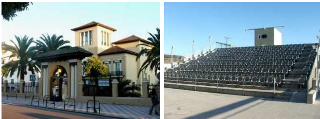
Figuras 138 y 139. Fachada y cine al aire libre del Teatro el Jardinito de Cabra (Ayuntamiento de Cabra).
