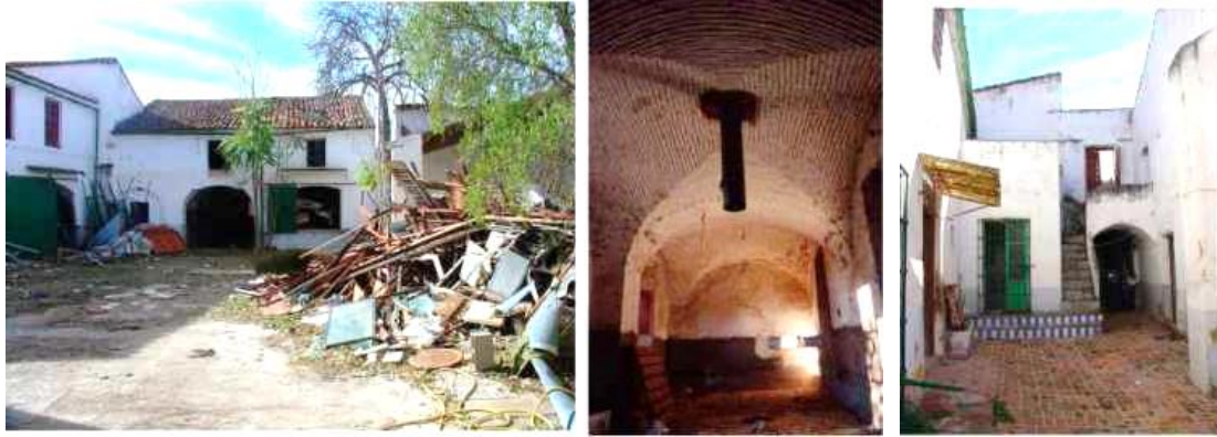
Figuras 1202 a 1204. Construcciones auxiliares de la vivienda número 24 antes de la rehabilitación (KRAHE MARINA, E.).
