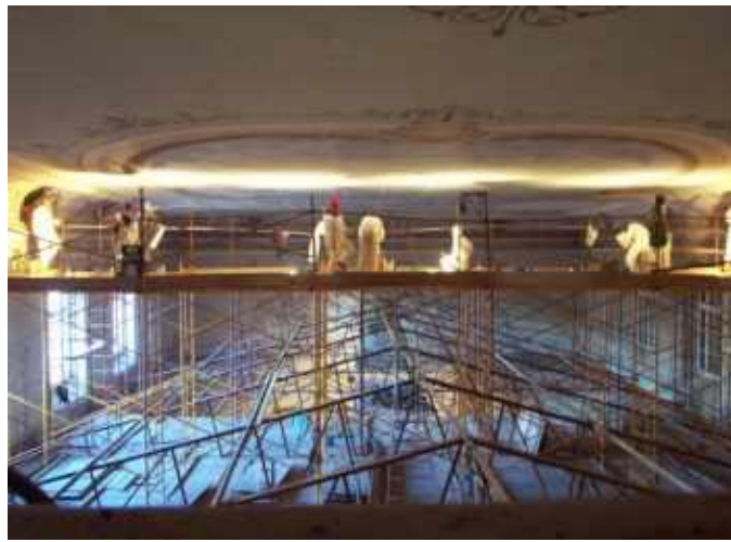
Figuras 502 y 503. Rehabilitación de la pintura en el techo del patio de butacas (LÓPEZ BERNAL, V., 2001).
