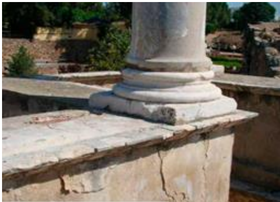
Figuras 229 y 230. Degradación y presencia de sales en morteros y acumulación de depósitos. (LUENGO, F. y PEREZ CHIVITE, M.P., 2014).
