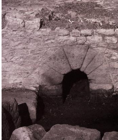
Figura 241. Desagüe bajo la escena (Foto LATOVA).
