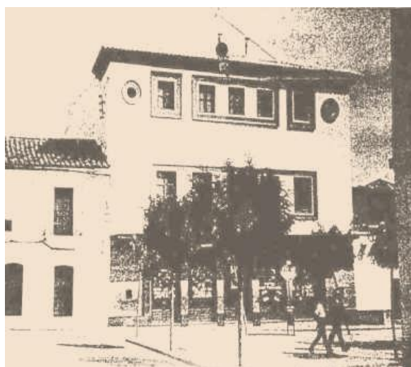
Figuras 917 a 919. Construcción del Cine San Fernando en los años cincuenta (PRIETO FERNÁNDEZ, J., 2000).
