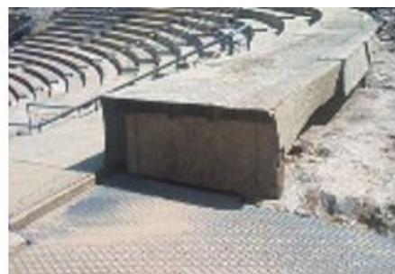
Figuras 215 y 216. Retirada de fragmentos con riesgo de desprendimiento y recolocación in situ (LUENGO, F. y PEREZ CHIVITE, M.P., 2014).
