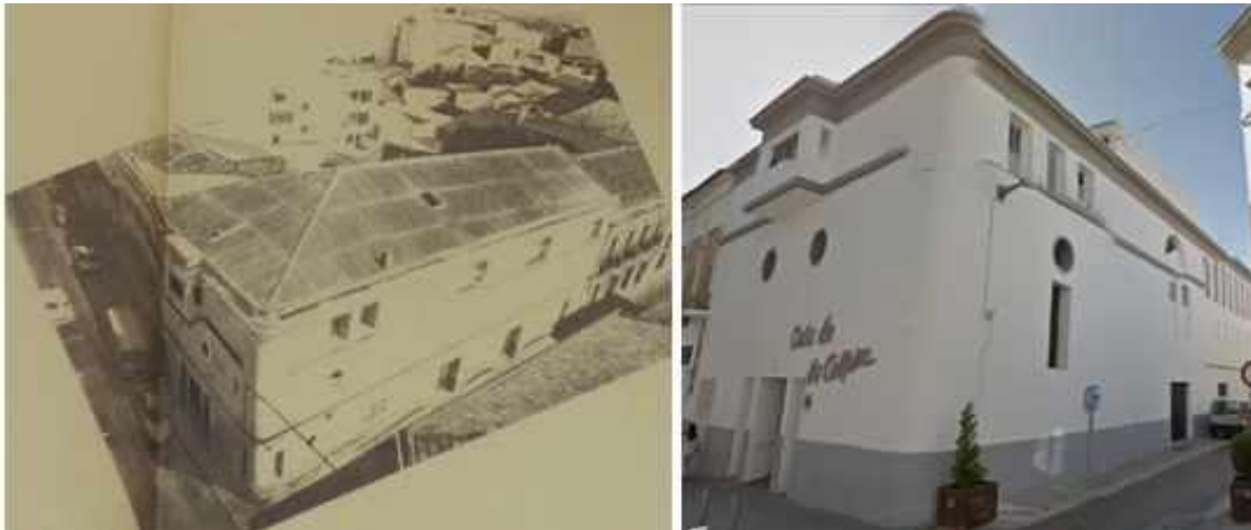
Figura 1390. Planos y fotografías del Cine Rialto de Villanueva de la Serena (MADRIGAL MARTÍNEZ-PEREDA, J., 1987).
