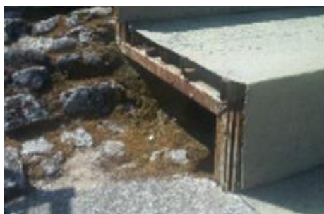
Figuras 215 y 216. Retirada de fragmentos con riesgo de desprendimiento y recolocación in situ (LUENGO, F. y PEREZ CHIVITE, M.P., 2014).
