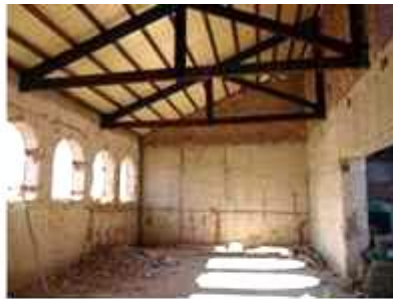
SUSTITUCION DE CUBIERTA VESTIBULO
