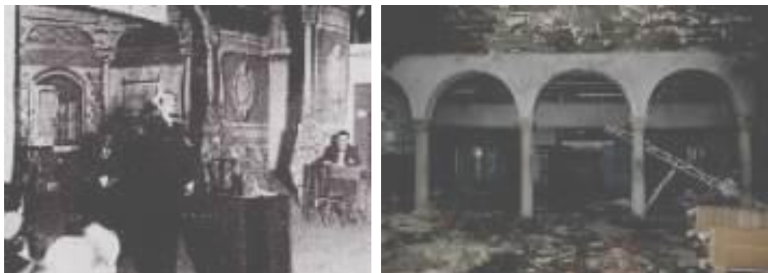
Figura 78. Fotografía de un acto celebrado en el teatro Principal en 1934 (Periódico Extremadura, CALDERA, J.) Figura 79. Fotografía del interior del solar, donde están columnas del teatro que se reubicaron para hacer una panadería (Periódico Extremadura, CALDERA, J.).
