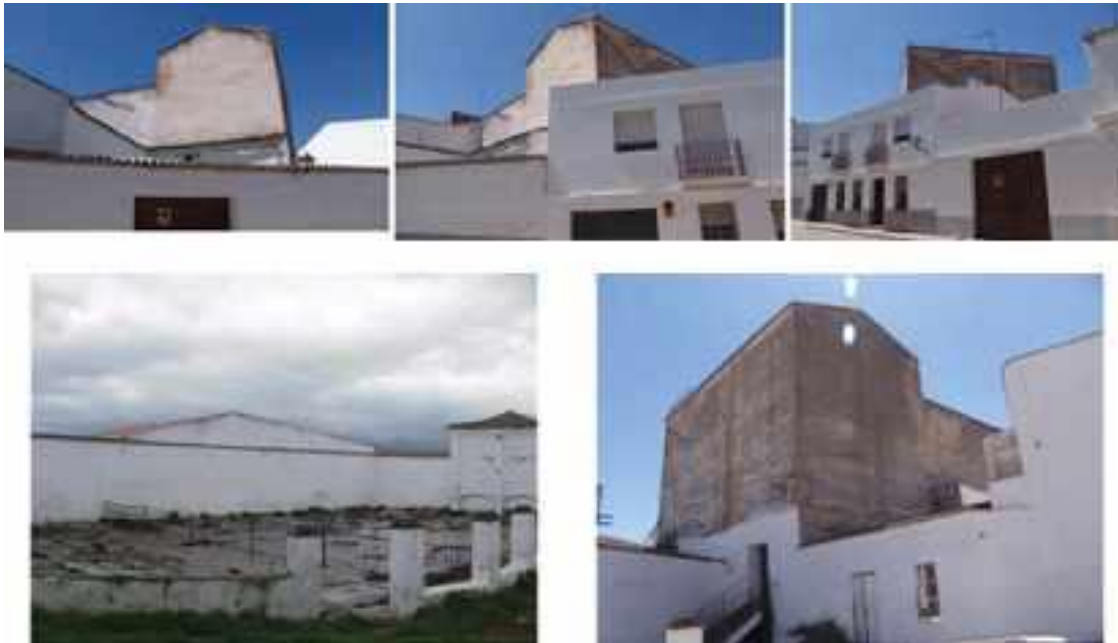
Figura 789. Fachada trasera y cine de verano antes de la rehabilitación (GALLEGO CANO, A.).
