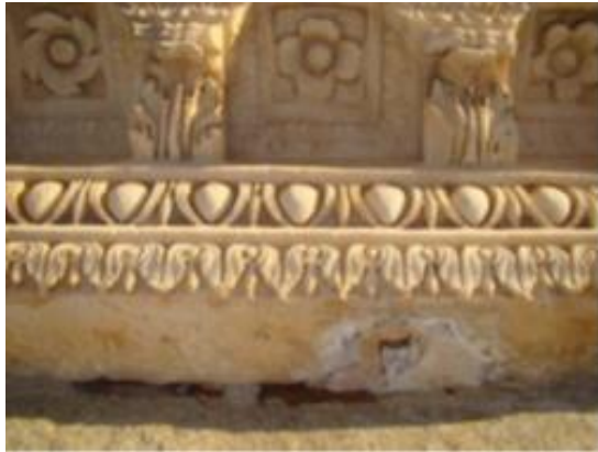
Figuras 225 y 226. Deterioro de los morteros de recubrición de las grapas, en diferente intensidad. (LUENGO, F. y PEREZ CHIVITE, M.P., 2014).
