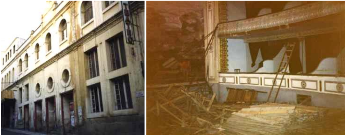
Figura 538. Fachada del Gran Teatro, antes de su rehabilitación. Figura 539. Estado del Gran Teatro, antes de su rehabilitación (Foto MARCHENA, AHMC).
