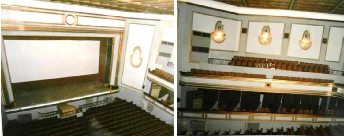
Figura 557. Vista del escenario y patio de butacas antes de la rehabilitación. Figura 558. Detalle de la pared y palcos del Teatro (MATESANZ VERA, P., SÁNCHEZ HERNÁNDEZ, C., 1996).
