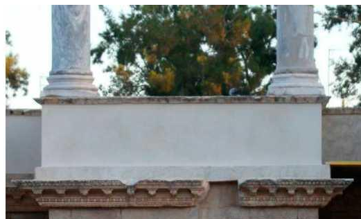
Figuras 218 y 219. Mapeado de daños antes de la intervención y reposición de enlucido de mortero de cal (LUENGO, F. y PEREZ CHIVITE, M.P., 2014).
