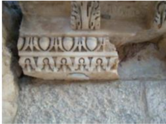
Figuras 225 y 226. Deterioro de los morteros de recubrición de las grapas, en diferente intensidad. (LUENGO, F. y PEREZ CHIVITE, M.P., 2014).
