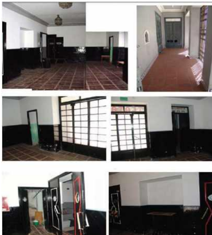
Figuras 781. Vestíbulo de entrada antes de la rehabilitación (GALLEGO CANO, A.).
