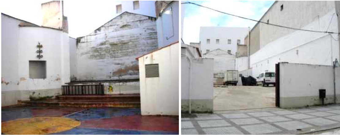
Figura 366. Escenario del antiguo cine de verano rehabilitado. Figura 367. Local colindante al Teatro rehabilitado.
