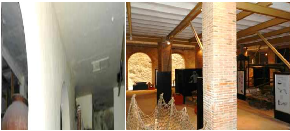
Figura 679. Techo de la bodega rehabilitado. Figura 680. Vista general del Museo Etnológico.
