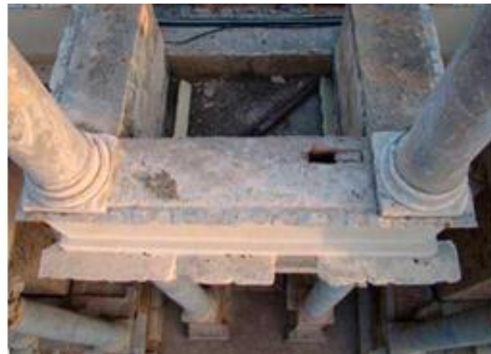
Figuras 229 y 230. Degradación y presencia de sales en morteros y acumulación de depósitos. (LUENGO, F. y PEREZ CHIVITE, M.P., 2014).
