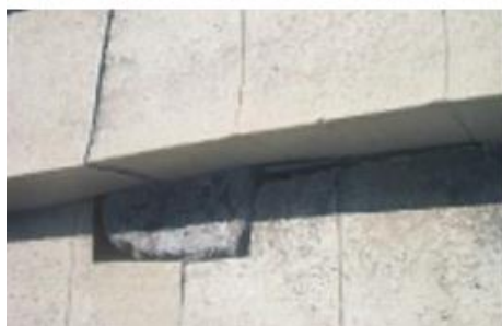
Figura 217. Construcción de gradas de poliéster en el Teatro Romano de Mérida.
