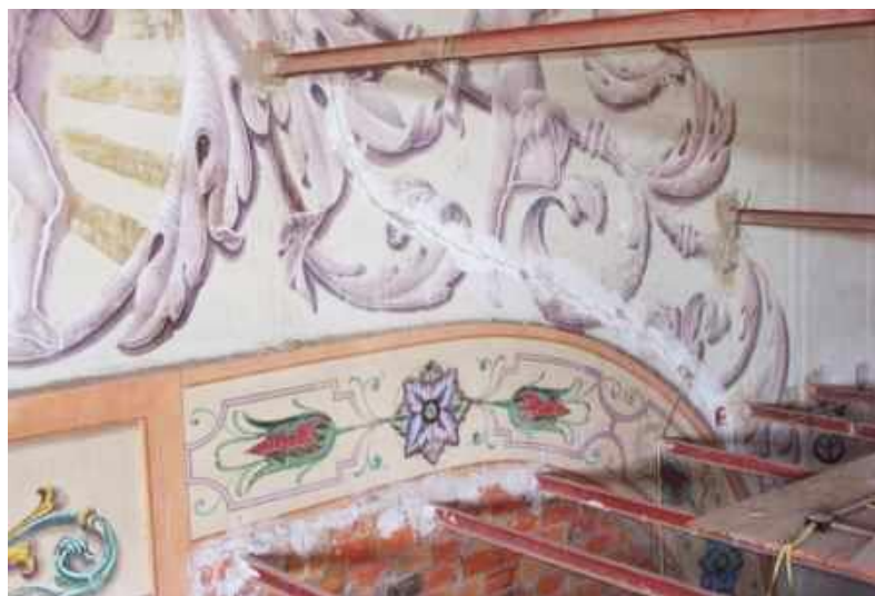
Figuras 501. Proceso de rehabilitación de la pintura en la boca del escenario (LÓPEZ BERNAL, V., 2001).
