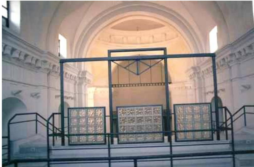
Figuras 1088 a 1103. Proceso de las obras (LÓPEZ GALÍNDEZ, J.A.).
