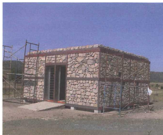
Figura 257. Vista de la caseta de entrada (MESA HURTADO y MARTÍNEZ VERGEL, 2002).
