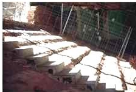
Figura 800. Sustitución de cubierta del vestíbulo, demolición de forjado y de peldaños de gradas (GALLEGO CANO, A.).
