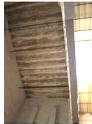
NUOVA CUBIERTA DE CAJA ESCENICA DE PLACAS ALVEOLARES
