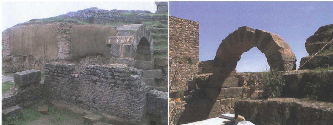
Figura 256. Vista de la restauración del arco de acceso (MESA HURTADO y MARTÍNEZ VERGEL, 2002).
