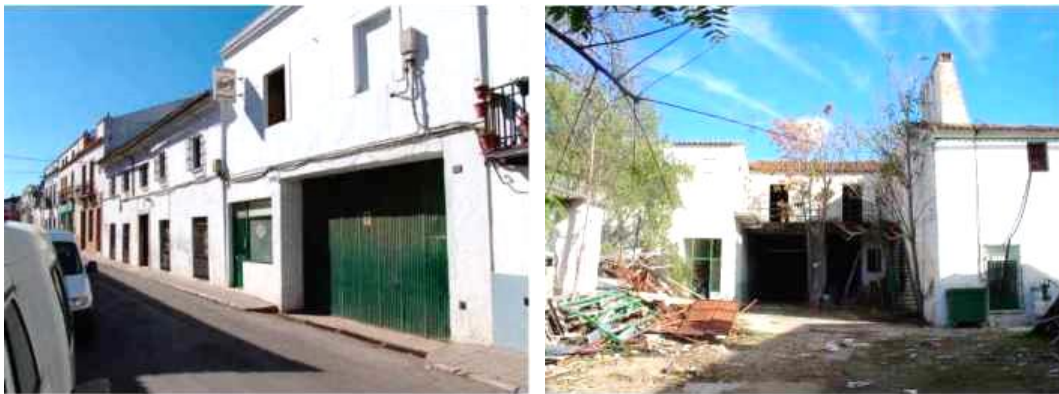
Figuras 1205 y 1206. Vivienda número 22 antes de la rehabilitación (KRAHE MARINA, E.).
