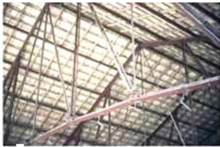
CUBIERTA EXISTENTE TRAS DEMOLER LA BOVEDA DE ESCAVOLA
