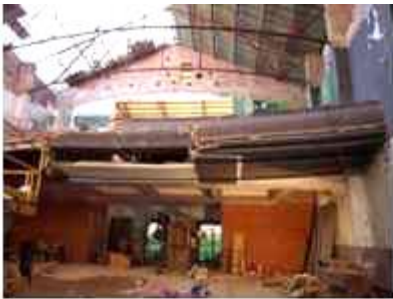
SUSTITUCION DE CUBIERTA DE NAVE PRINCIPAL
