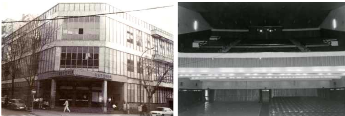
Figuras 89 y 90. Cine Astoria, fachada y patio de butacas al comienzo de su desmantelamiento (AMC).
