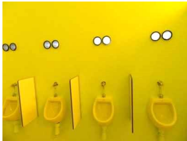
Figuras 1222, 1223 y 1224. Detalles decorativos de los urinarios del Teatro Municipal de Zafra.
