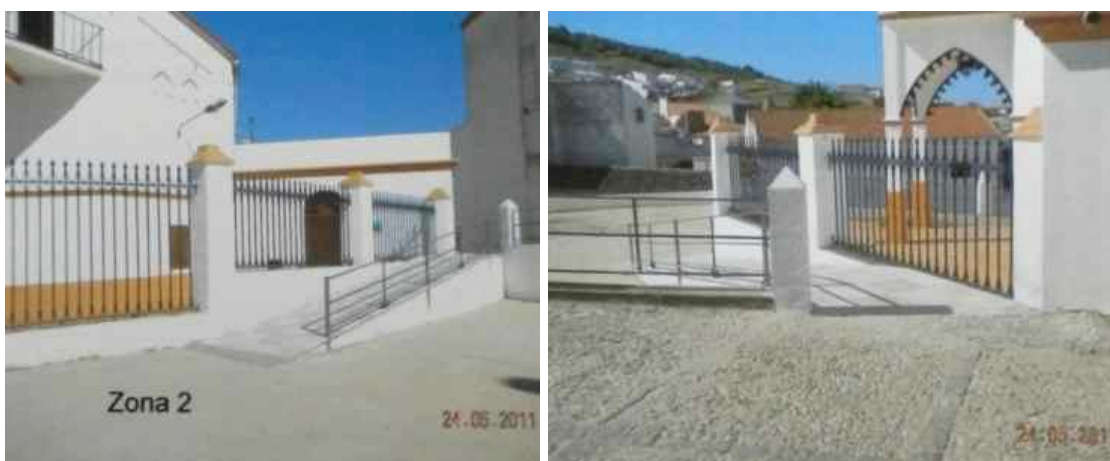
Figuras 354 y 355. Rampa acceso vía pública (BARCO, E., 2011).
