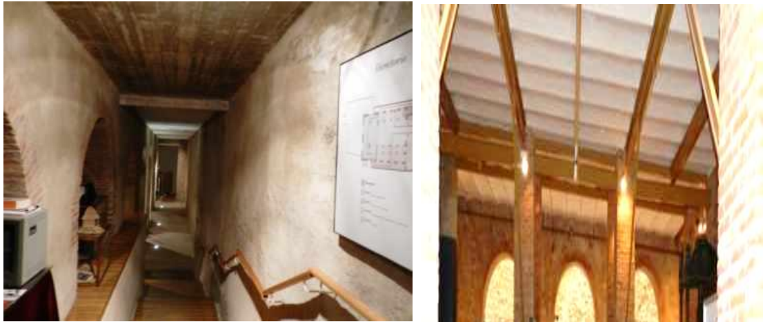
Figura 677. Pasillo de entrada tras la rehabilitación. Figura 678. Techo del sótano rehabilitado.
