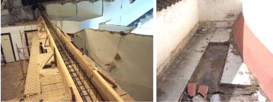
Figuras 1046 y 1047. Fotografías del proceso de rehabilitación (LÓPEZ BERNAL, V., 1992).
