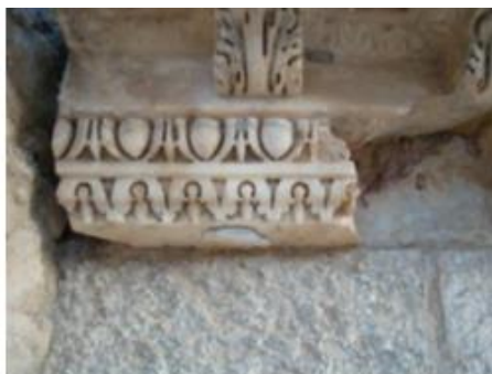
Figuras 223 y 224. Deterioro de los morteros de recubrición de las grapas, en diferente intensidad. (LUENGO, F. y PEREZ CHIVITE, M.P., 2014).
