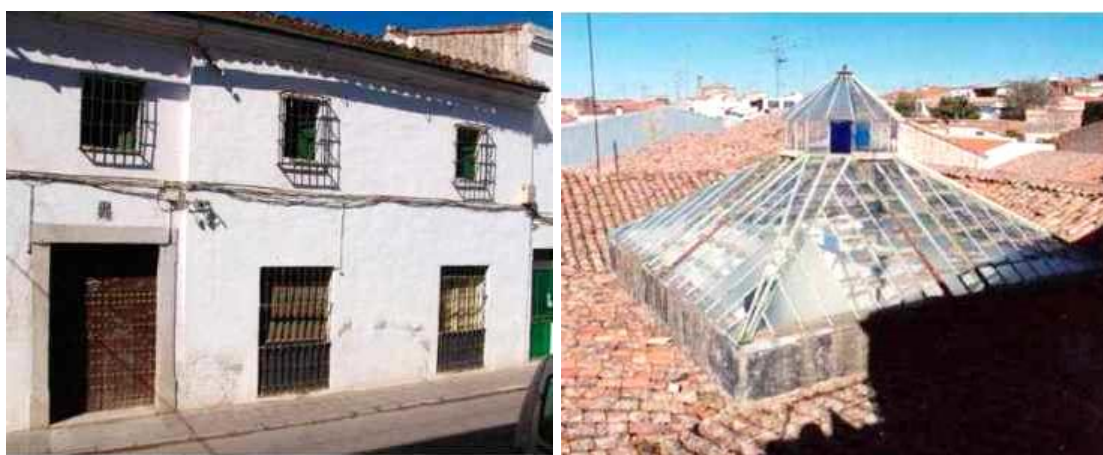
Figuras 1200 y 1201. Vivienda número 24 antes de la rehabilitación: fachada y montera del patio (KRAHE MARINA, E.).
