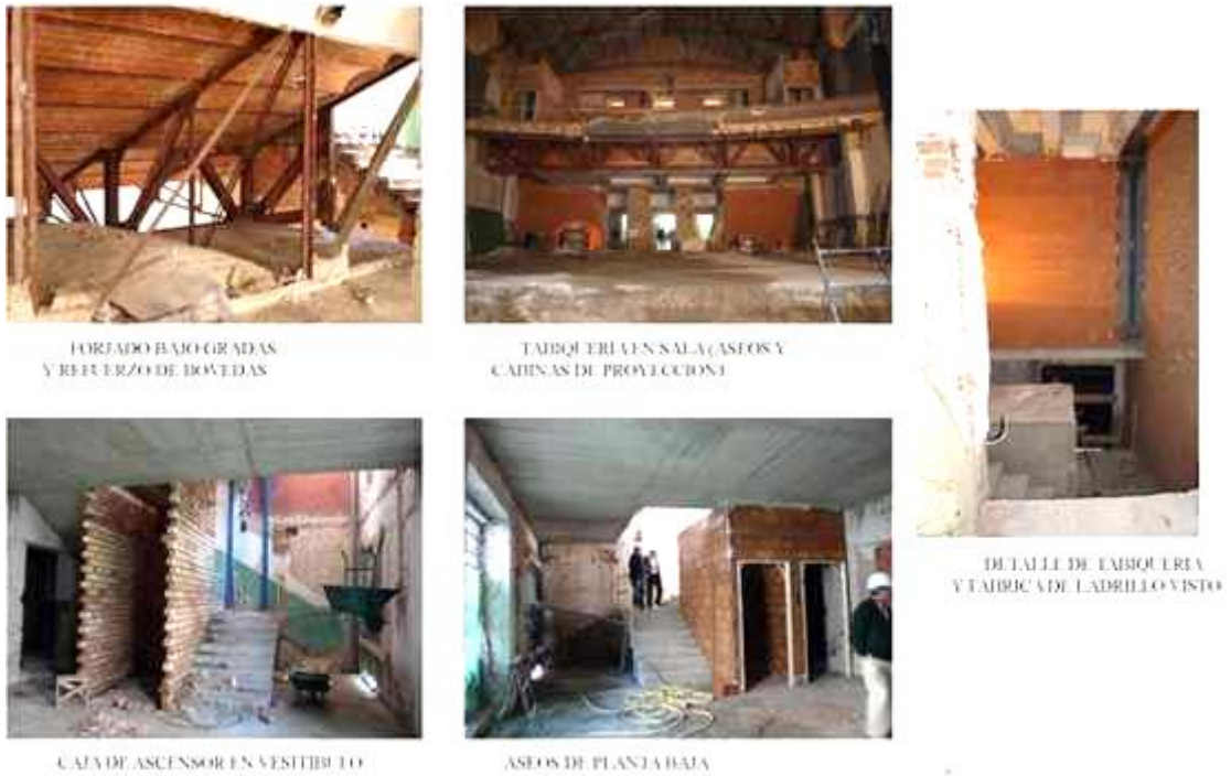
Figura 802. Forjado bajo gradas, tabiquería en sala, caja de ascensor y aseos (GALLEGO CANO, A.).
