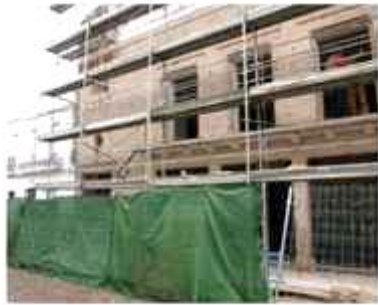
REVESTIMIENTO DE FACHADA
