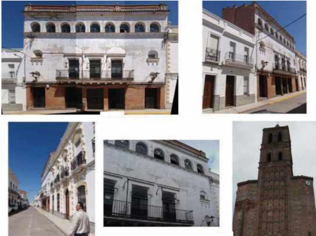
Figura 780. Fachada principal y edificios colindantes antes de rehabilitación (GALLEGO CANO, A.).
