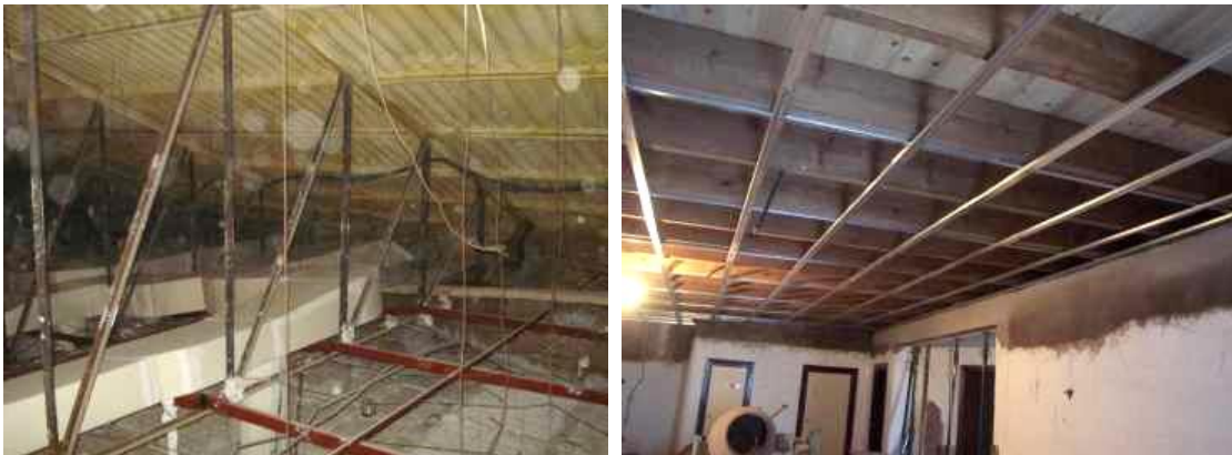
Figuras 1044 y 1045. Fotografías del falso techo de la sala principal (LÓPEZ BERNAL, V., 1992).
