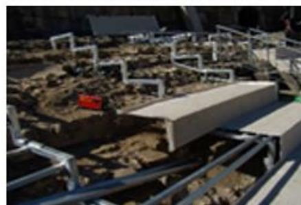
Figura 217. Construcción de gradas de poliéster en el Teatro Romano de Mérida.
