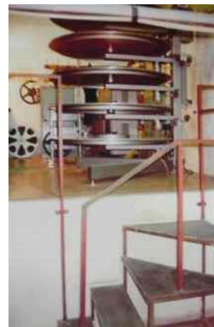
Figura 584. Nivel inferior de la cabina de proyección (planta segunda). En la parte izquierda está la cámara de la sala principal, y la del minicine a su derecha. Esta última proyecta la imagen reflejándola en dos espejos para salvar la altura entre el objetivo del proyector a 1,20 metros y la ventana del minicine, que se encuentra enrasada con el suelo. El equipo de megafonía se encuentra a la parte izquierda de la foto. Figura 585. Nivel superior de la cabina de proyección. En la parte inferior de la foto se encuentra la escalera metálica que salva el desnivel entre ambas zonas. En la zona superior están los platos donde se colocan las películas para la proyección. Las películas discurren desde estos platos hasta las cámaras mediante un sistema de poleas (VALVERDE LORENZO, L.R, 1996).
