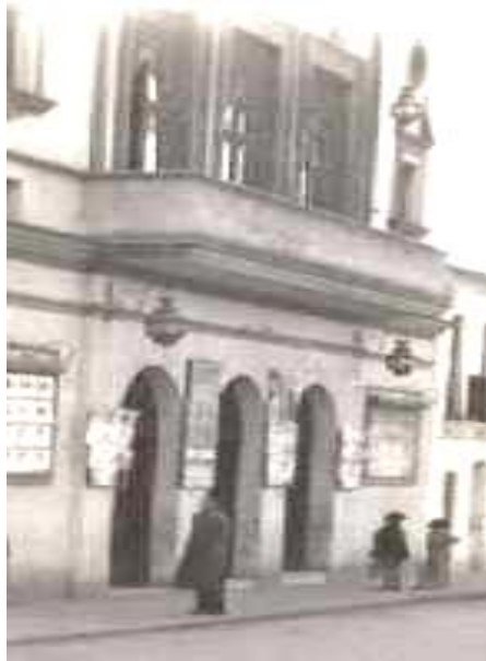
Figura 815. Fachada del Teatro Capitol antes de rehabilitarse (AMAZ).
