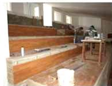
REVESTIMIENTO DE MADERA ESCALERAS VESTIBULO Y GRADERIO
