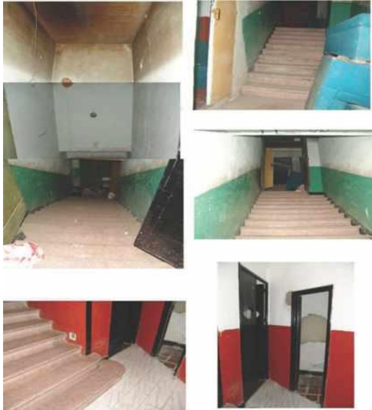
Figura 784. Escalera del vestíbulo antes de la rehabilitación (GALLEGO CANO, A.).
