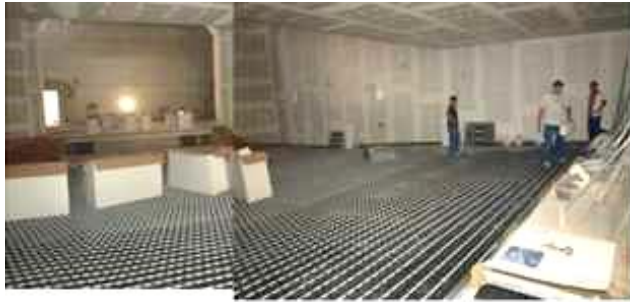
SUELO RADIANTE EN SALA PRINCIPAL
