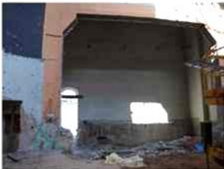
Figura 800. Sustitución de cubierta del vestíbulo, demolición de forjado y de peldaños de gradas (GALLEGO CANO, A.).
