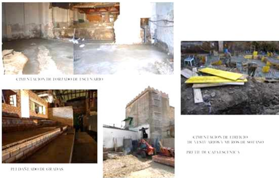
Figura 803. Cimentación de forjado de escenario y cimentación de edificio de vestuarios y muros de sótano (GALLEGO CANO, A.).
