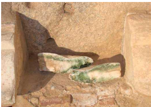
Figuras 215 y 216. Retirada de fragmentos con riesgo de desprendimiento y recolocación in situ (LUENGO, F. y PEREZ CHIVITE, M.P., 2014).
