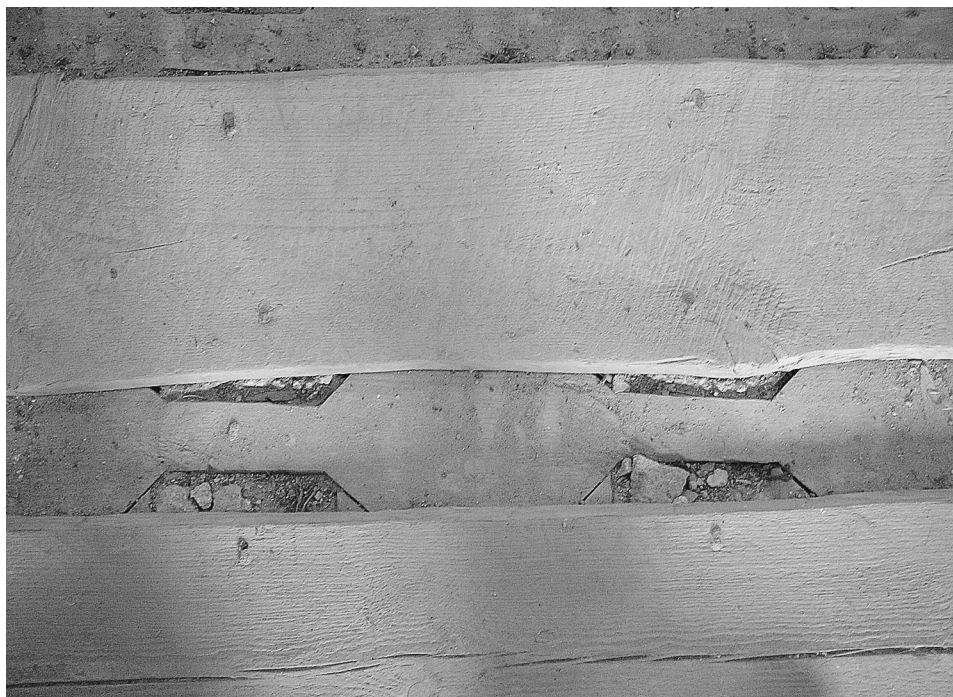
FIGS. 3 Y 4. Panorámica y detalle de un forjado de cintas y saetinos.
