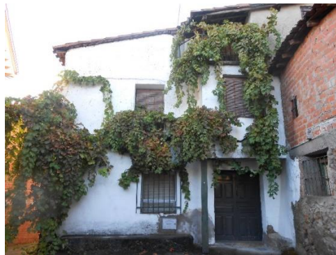
Figura 2.36: Vivienda en calle Parrales, Casas del Castañar, (elaboración propia).
