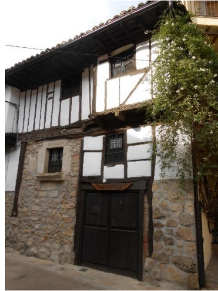
Figura 2.17: Vivienda de entramado de madera en calle Real de Arriba, Tornavacas (elaboración propia).
