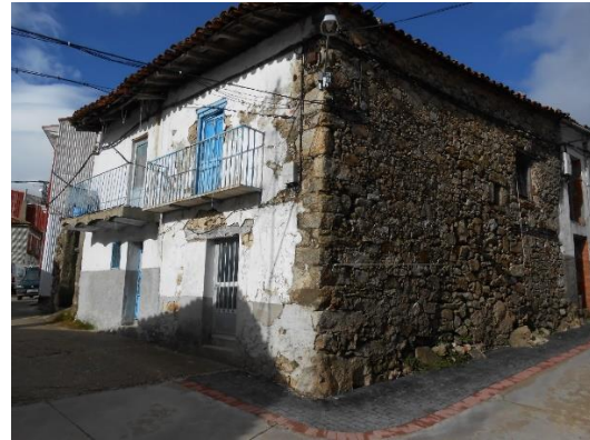
Figura 2.26: Vivienda serrana con fachada encalada y ejecución de vuelos posteriores a la fecha de construcción real, y fachada vista en calle Montera, Piornal, (elaboración propia).
