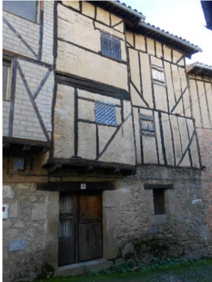
Figura 2.16: Vivienda de entramado de madera en calle Portugal, Guijo de Santa Bárbara (elaboración propia).
