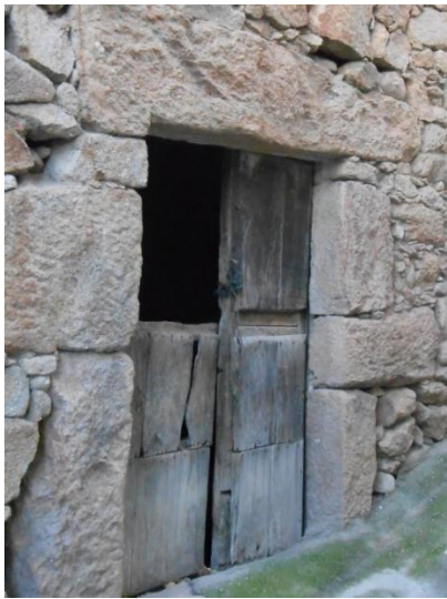
Figura 2.32: Puerta de tres hojas con dintel y jambas de granito, en calle el Portal, El Torno. (elaboración propia).
