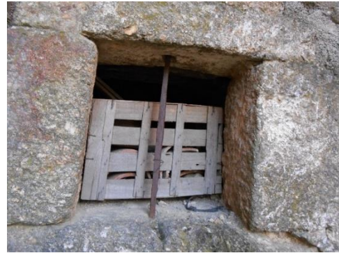
Figura 2.33: Ventana en vivienda de calle Prrales, Casas del Castañar, (elaboración propia).
