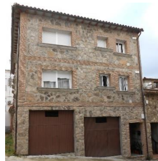
Figura 2.40: Vivienda unifamiliar en el centro del municipio de Casas del Castañar, (elaboración propia).
