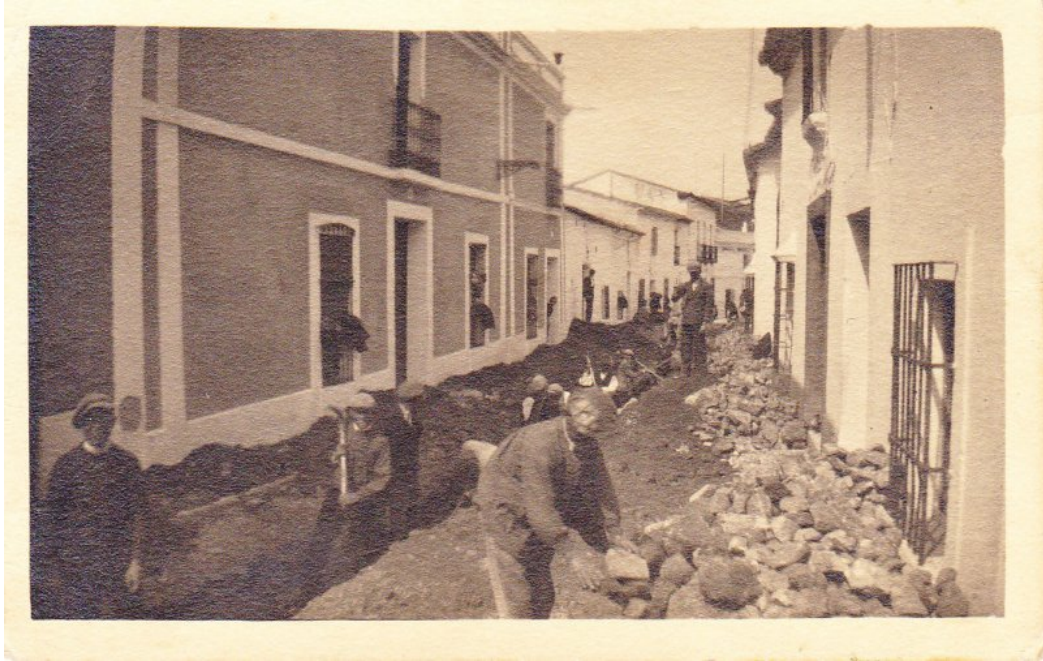
Fotografía 40. Albañiles trabajando en la primera obra de canalización de agua y saneamiento público de la C/ Sevilla (foto 653 o ALBA0679)
