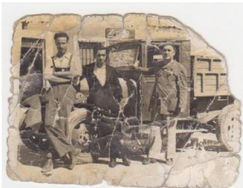
Fotografía 18. Félix Sanabria Muñoz con el camión de reparto de las Bodegas Blanco (foto 447 o BODE0005)
