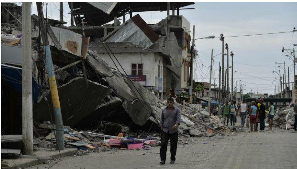
Ilustración 1 Residencias destruidas por el terremoto en Manta 2016
