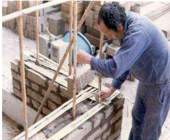
Ilustración 52 Vivienda de adobe, con reforzamiento de caña
