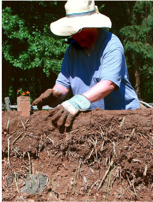
Ilustración 28 Construcción de pared de mano, Ecuador
