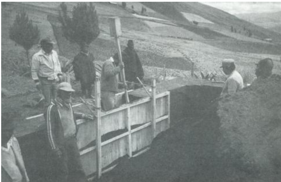
Ilustración 29 Construcción de casas de tapial, Cotopaxi, Ecuador
