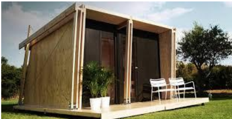
Ilustración 21 Ejemplo de caseta construida con sistema desmontable
