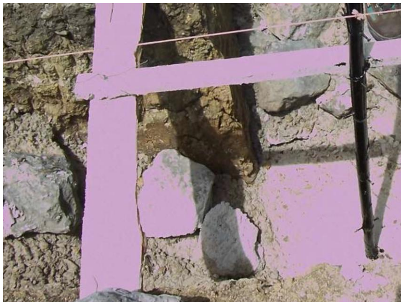
Ilustración 51 Vivienda de adobe, construcción de cimientos
