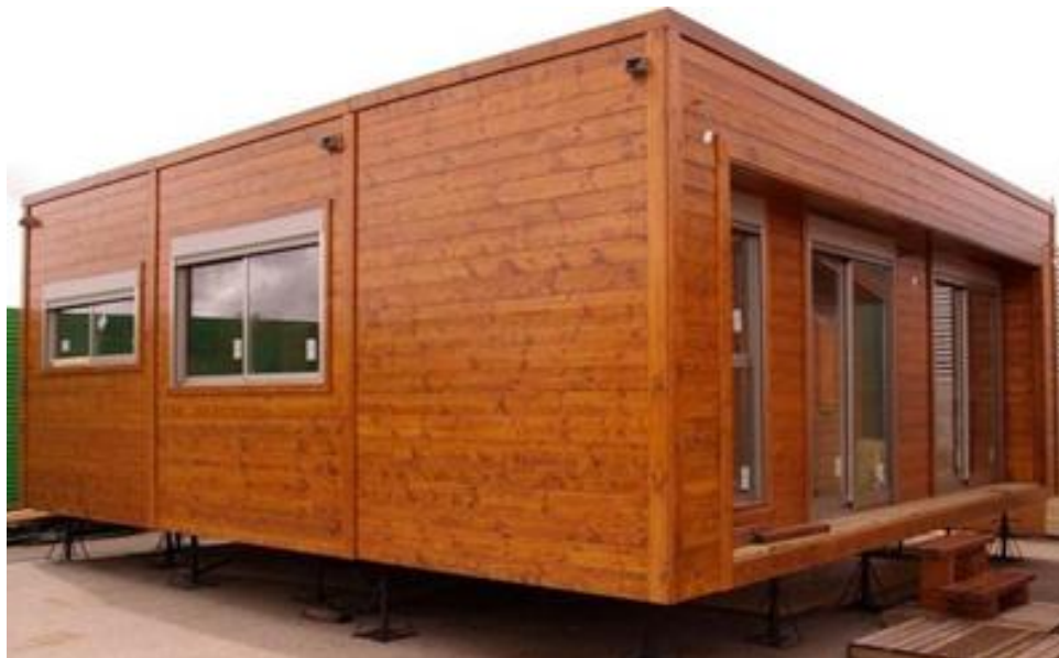
Ilustración 22 Casas prefabricadas de madera
