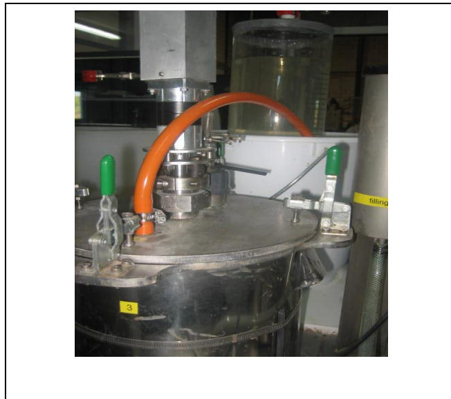
Fig. 2.4. Tapas de entrada y salida y recolección del biogás del digestor.
