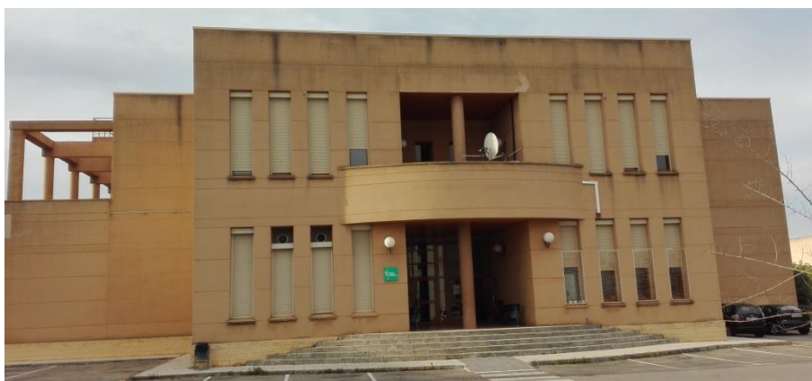
Figura 3. Fachada principal del edificio de Telecomunicaciones de Politécnica de la UNEX.
