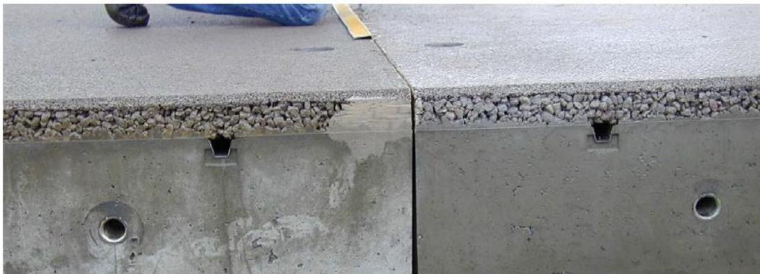
b. Sección de las piezas prefabricadas Modieslab
