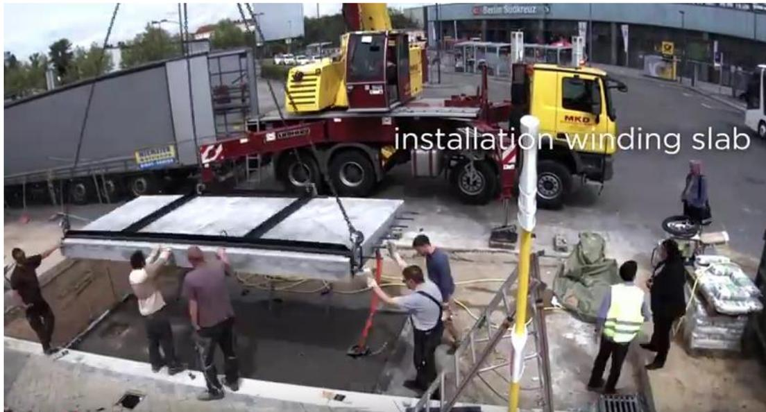
Figura 25. Puesta en obra del sistema Primove Bombardier
