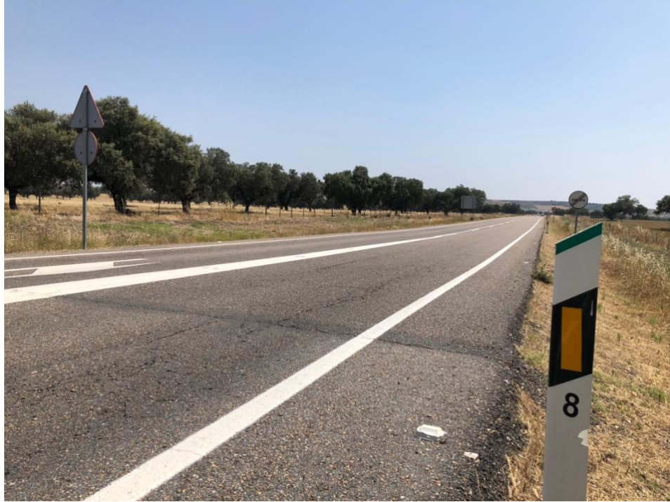
Imagen 1. P.K. 50+800. Inicio acondicionamiento.
