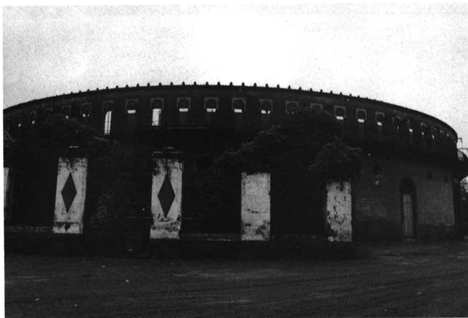
Fig. 5. Plaza de toros. Vista exterior.
