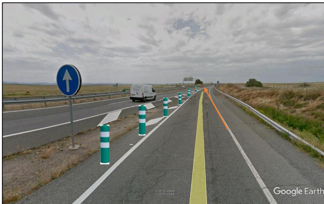
*Figura 4.3.31.- (Google-Propia). Prolongación visual de línea blanca de arcén imposible de cumplir con las balizas cilíndricas, pues se condicionaría el tránsito de ciclistas.*
