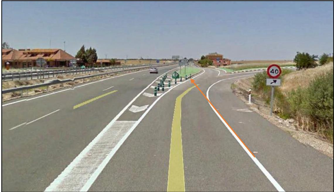
*Figura 4.3.23.- (Google-Propia). Propuesta Vista 2: cumple con la prolongación visual de línea blanca arcén derecho cubierta con balizas.*
