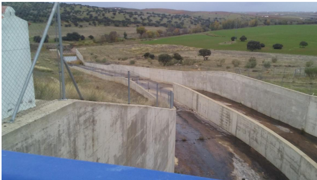
Figura 18: Vista del aliviadero desde la coronación de la presa.
