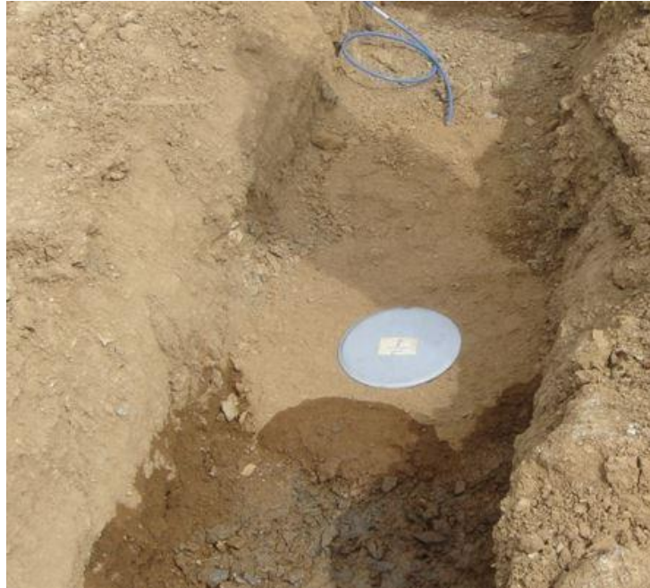
Figura 21: Células de presión total y piezómetro durante su instalación en obra. Fuente:(Fernando Aranda Gutiérrez, 2015)
