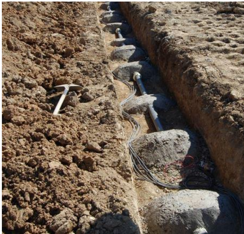
Figura 22: Extensómetros de cadena durante su instalación en obra. Fuente:(Fernando Aranda Gutiérrez, 2015)
