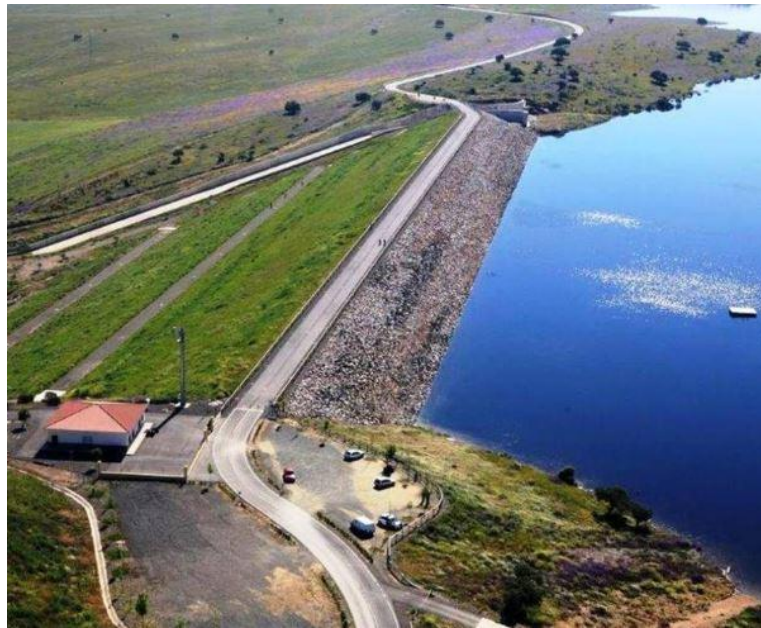
Figura 1: Vista aérea de la presa. Fuente: (Rivera, 2014)
