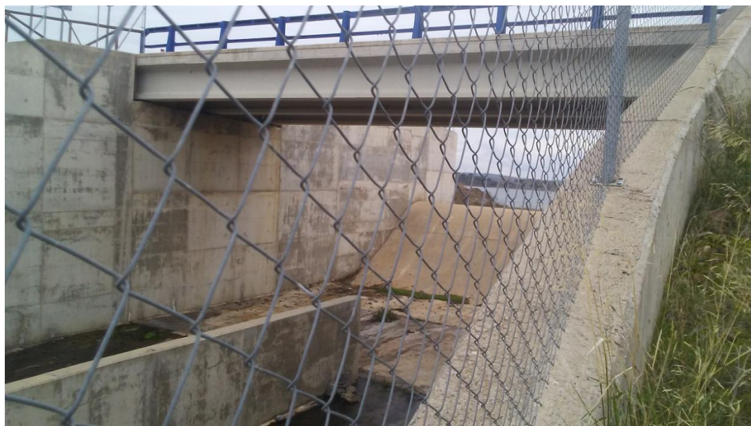
Figura 19: Inicio del aliviadero vista aguas abajo.
