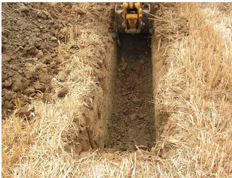
Figura 13: Calicata realizada durante la campaña de ensayos previos a la ejecución del cuerpo de la presa. (Fernando Aranda Gutiérrez, 2015)
