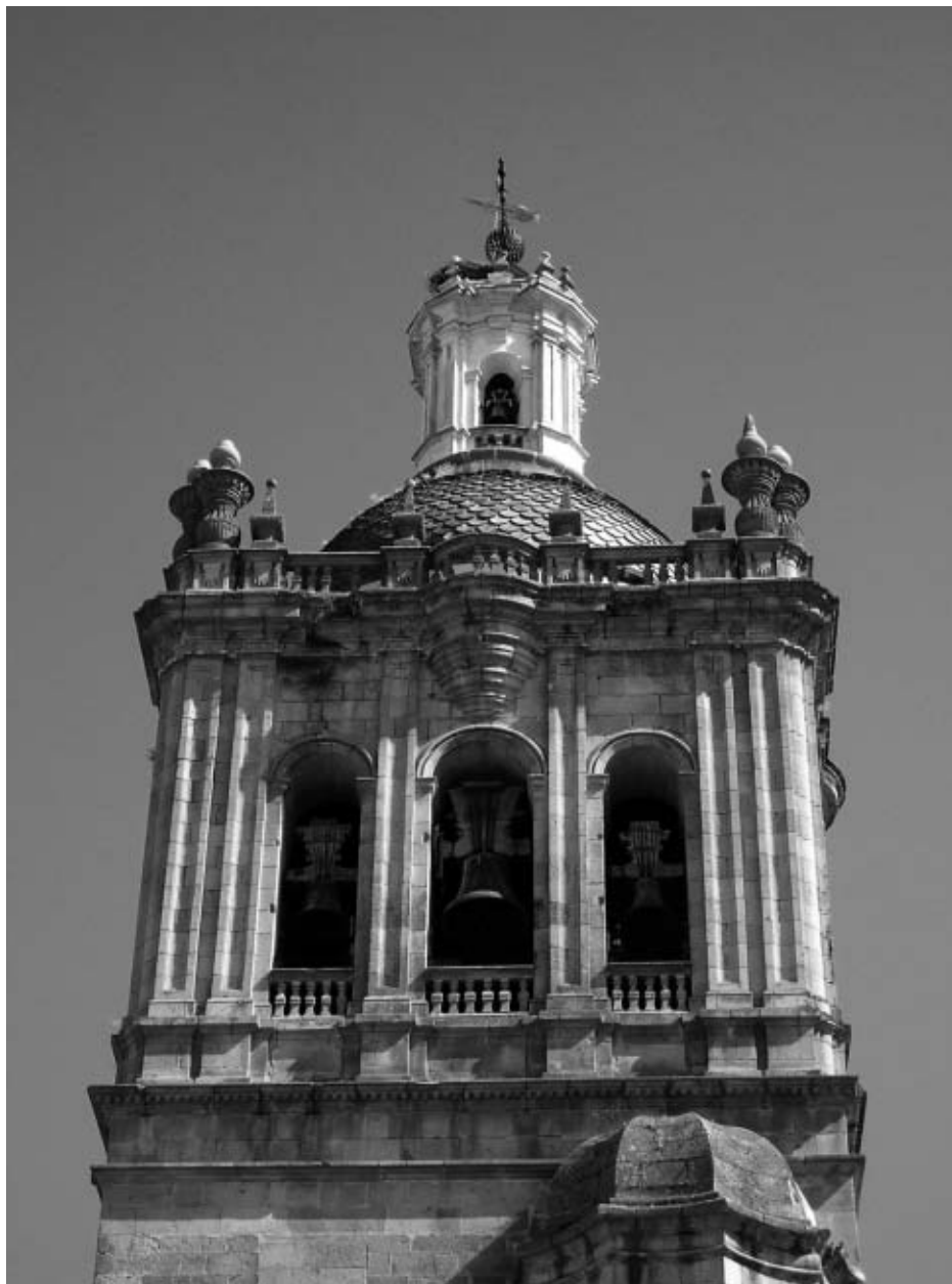
1. Campanario de la Catedral de Coria, vista desde el exterior 12
