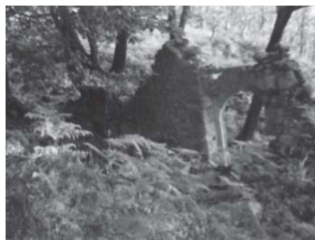
Restos Arquitectónicos del Convento de Santiago en Cerro Moncalvo
